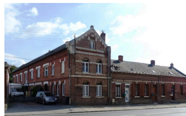
L'ancienne fabrique Lavallard et des logements ouvriers. Phot. Isabelle Barbedor IVR32_20168005762NUCA
