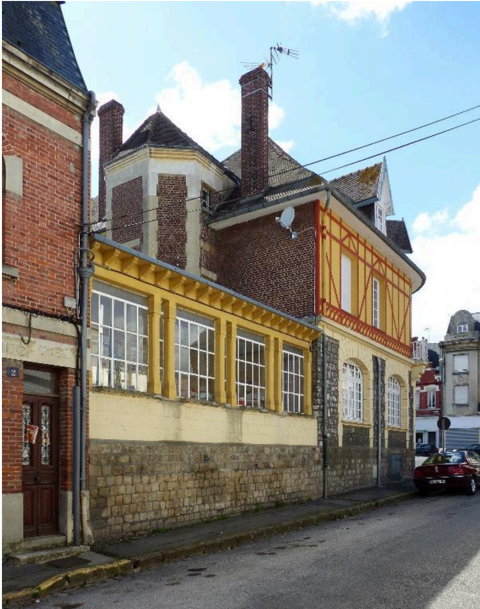
Vue des façades sur la rue Beauvois.
