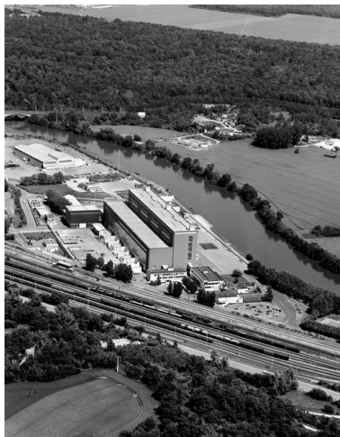
Vue aérienne de la centrale électrique vers le sud-est, en 1995 (Sanson Aviation). Phot. Sanson Aviation IVR22_19956000846X
