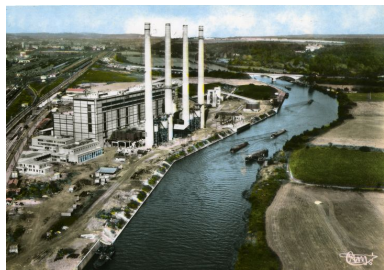
Vue générale de la centrale électrique après sa construction. Phot. Clarisse Lorieux IVR22_20106003163NUCAB
