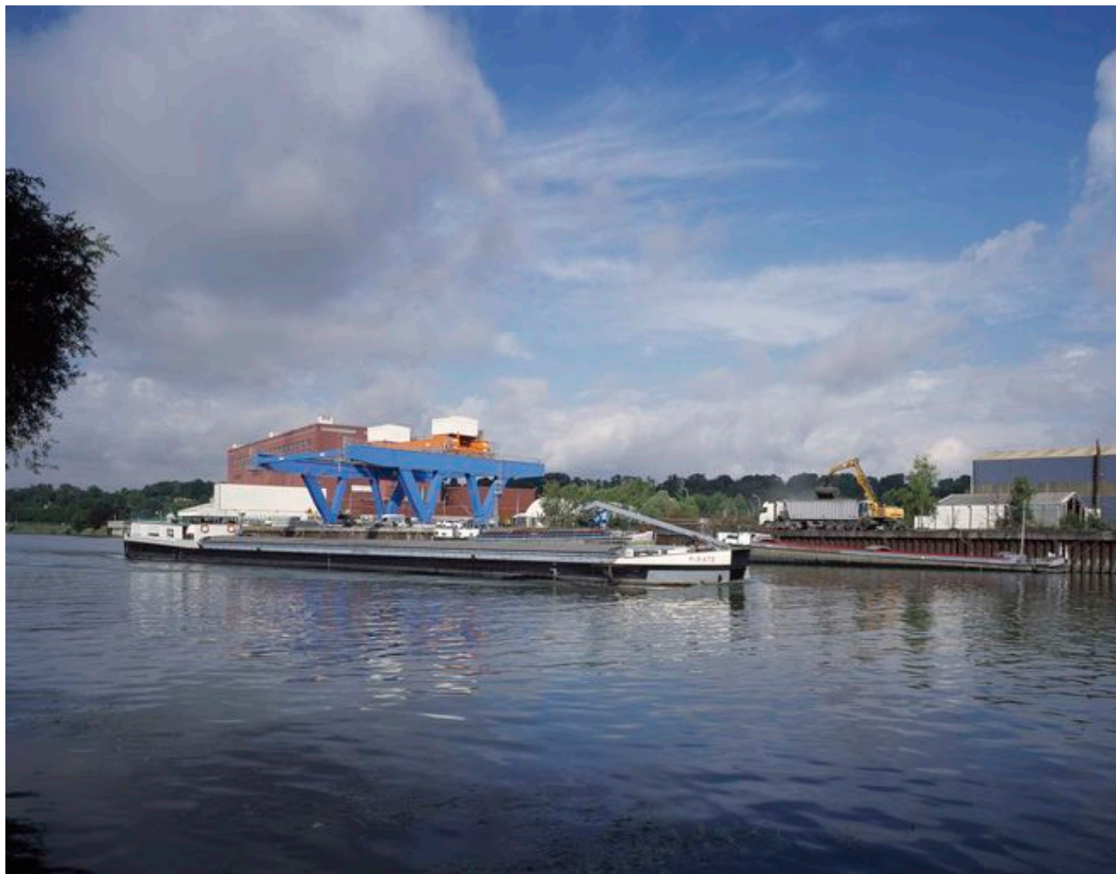
Portique pouvant soulever 500 tonnes au bord de l'Oise.
