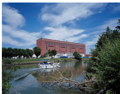
Vue générale de l'ancienne centrale électrique depuis la rive gauche de l'Oise. Phot. Thierry Lefébure IVR22_20106000279VA
