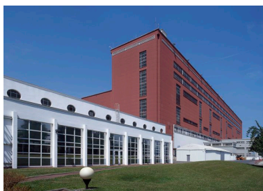
Au premier plan, les vestiaires, douches et le restaurant et dans son prolongement la salle des machines et la chaufferie. Phot. Thierry Lefébure IVR22_20106000519NUCA
