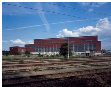
L'ancienne centrale depuis les voies ferrées. Phot. Thierry Lefébure IVR22_20106000276VA
