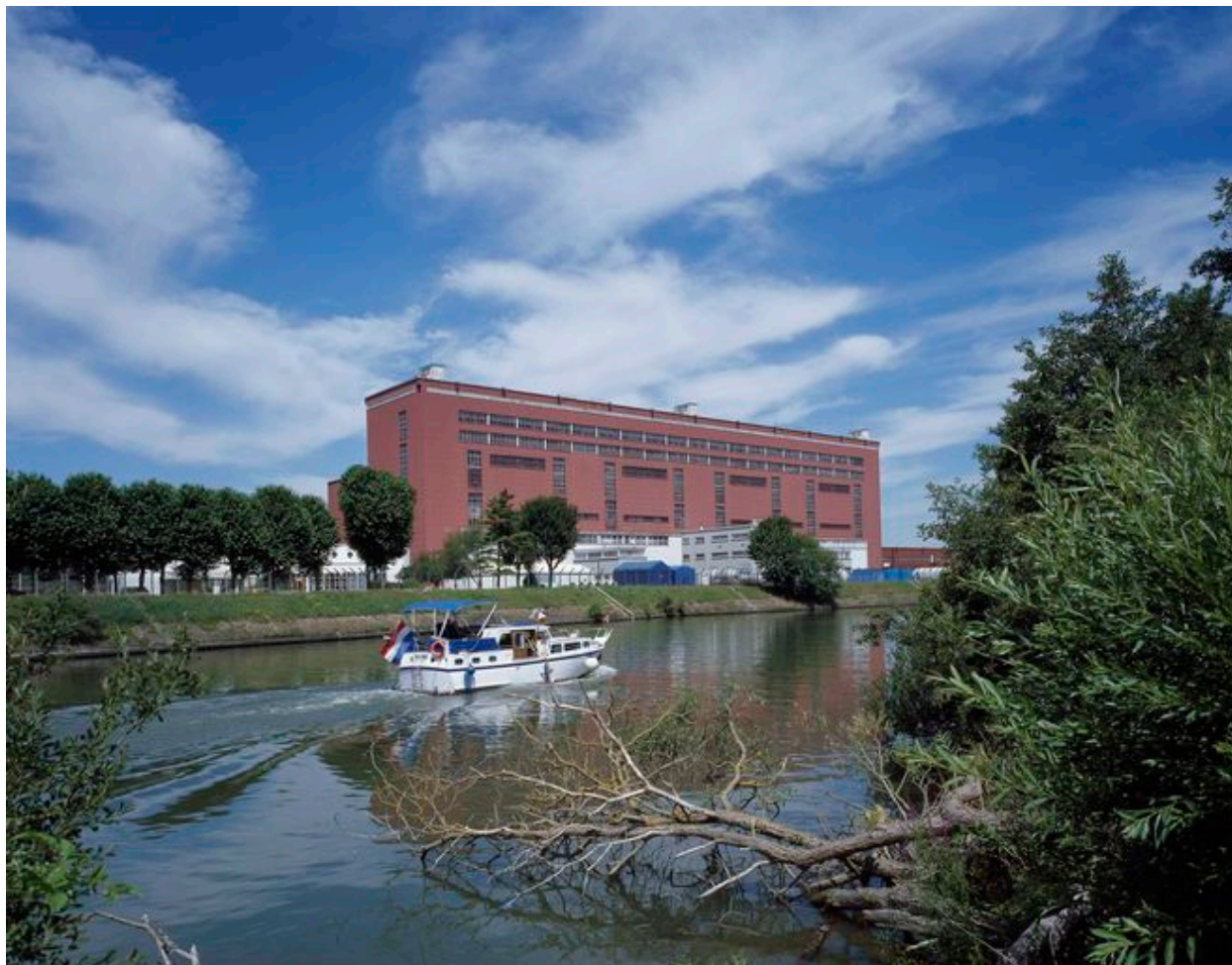
Vue générale de l'ancienne centrale électrique depuis la rive gauche de l'Oise.
