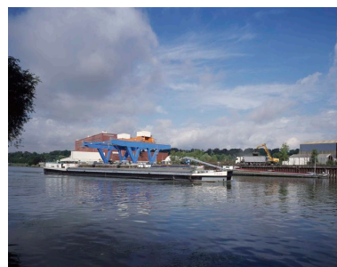
Portique pouvant soulever 500 tonnes au bord de l'Oise. Phot. Thierry Lefébure IVR22_20106000516VA
