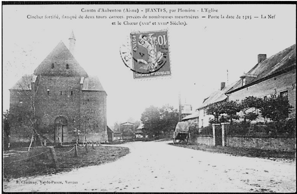
Façade occidentale de l'église (AP).
