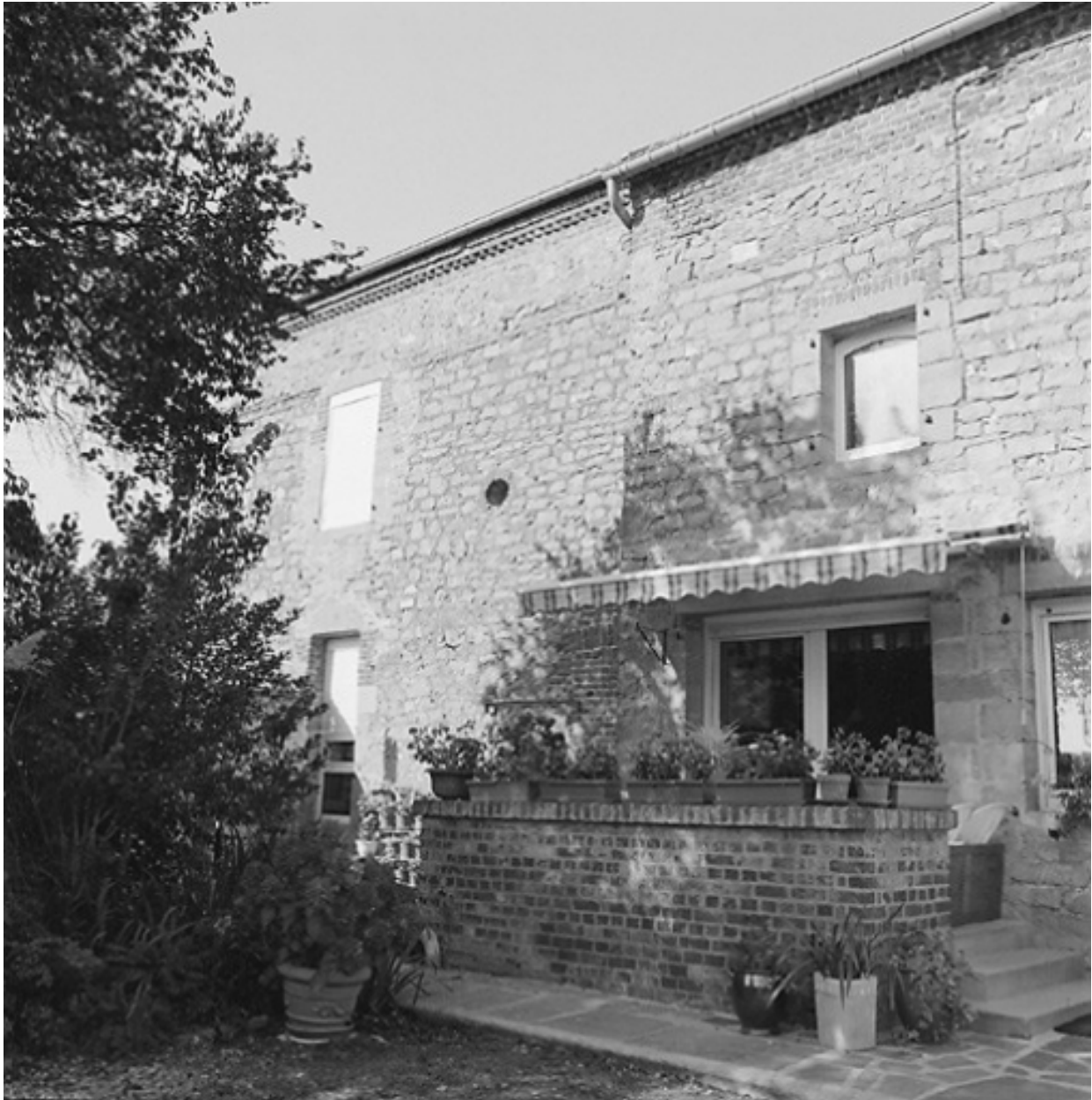
Vue de l'élévation postérieure du logis.
