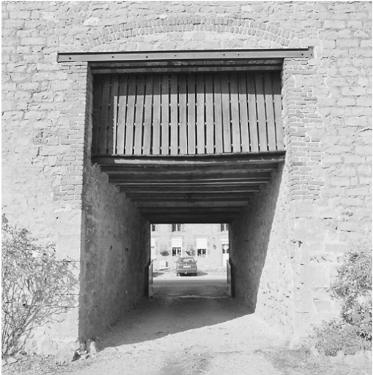
Vue du passage chartier, depuis la cour.
