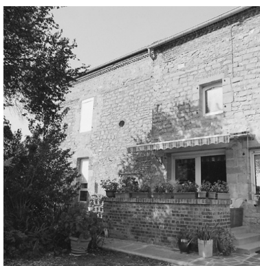
Vue de l'élévation postérieure du logis.
