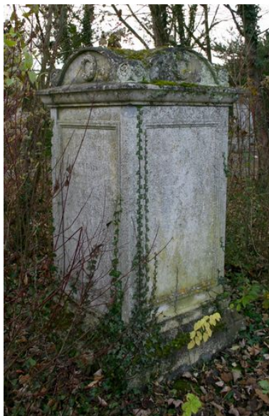
Pilier couronné. Phot. Caroline Vincent IVR22_20078001357NUCA
