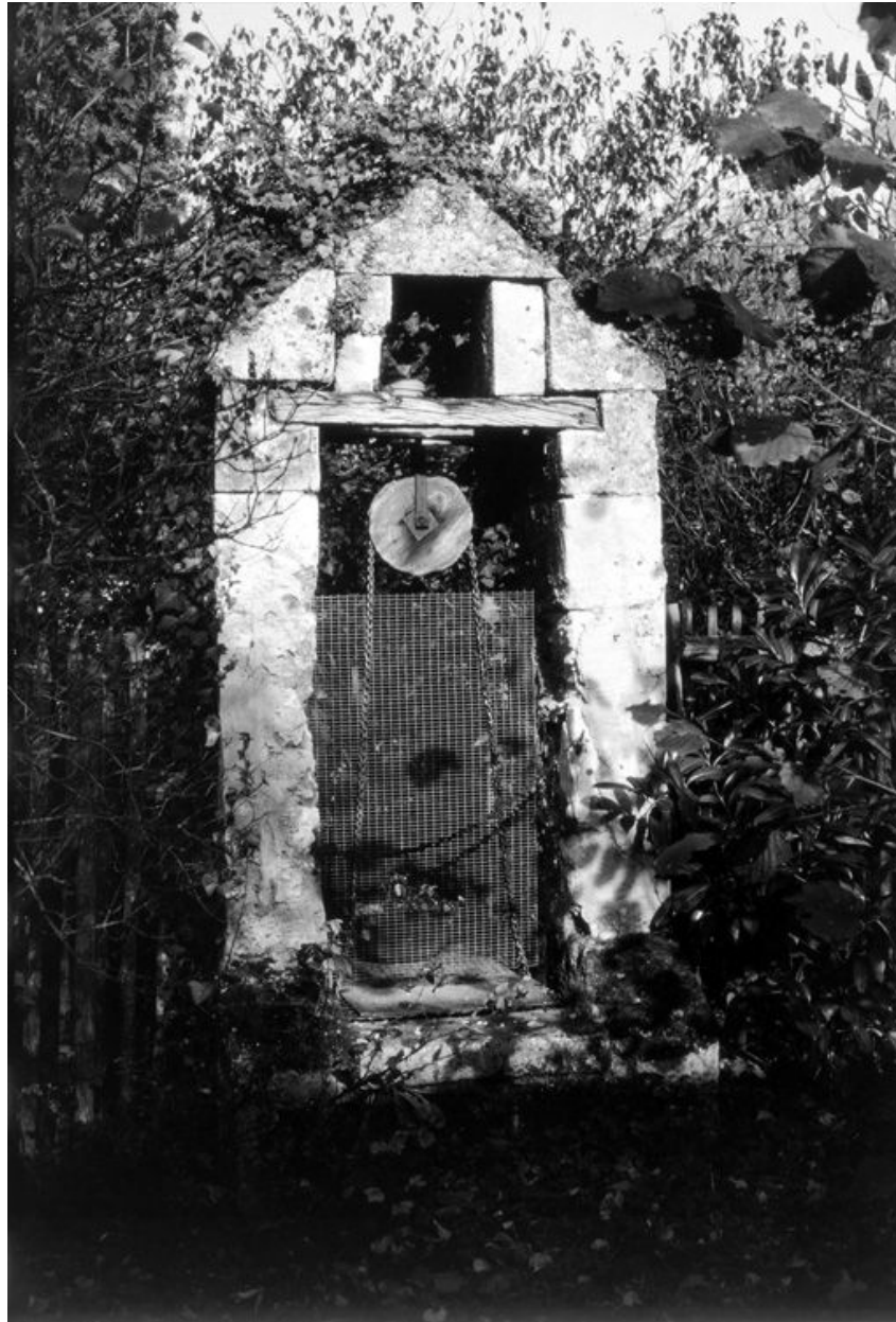
CUTS. Le Jonquoy. Ce puits, situé en limite de mitoyenneté, a été conçu avec deux ouvertures.
