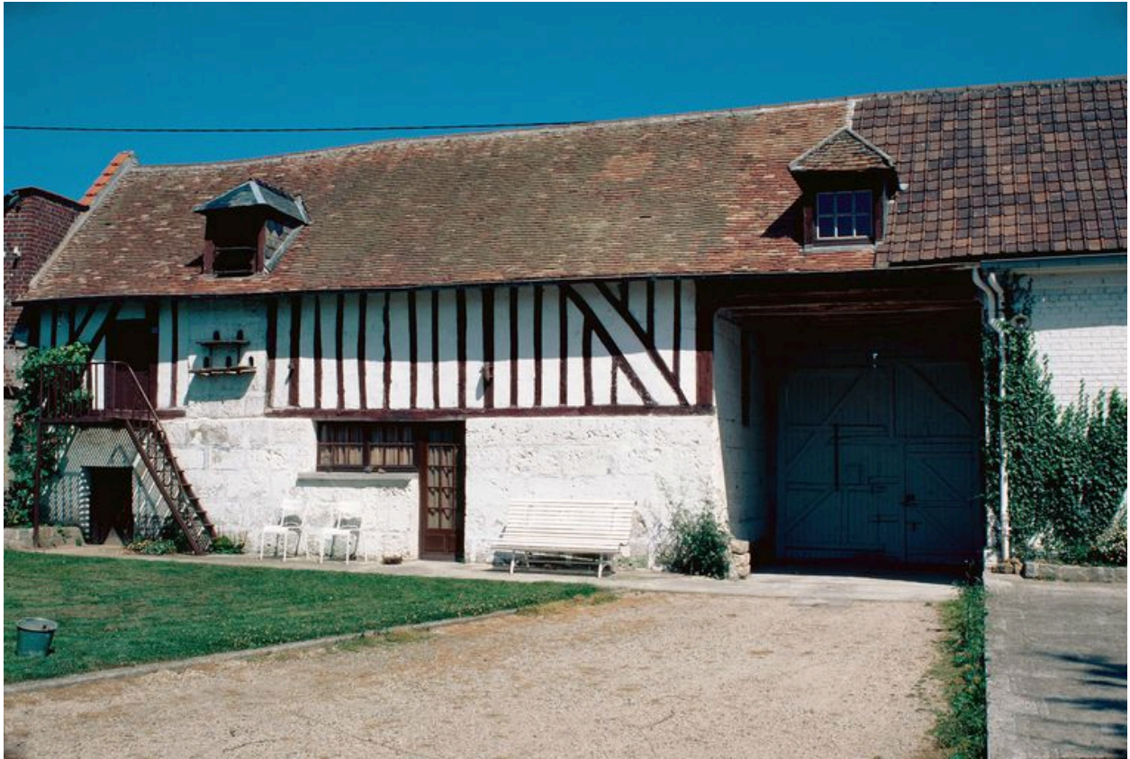
VILLE. Elévation antérieure de la grange d'une ferme repérée.
