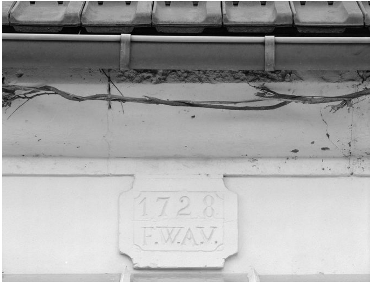
BABOEUF. Vue de la corniche de la ferme repérée rue de l'Eglise
