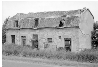
CUTS. Maison. Phot. Jean-Michel Périn IVR22_19856000783X
