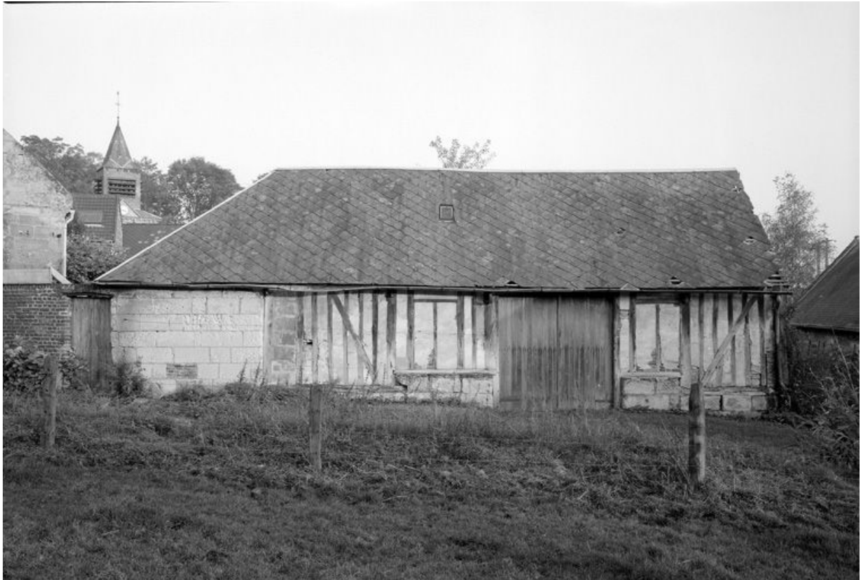
BEHERICOURT. Vue d'une grange (rue Saint-Martin).
