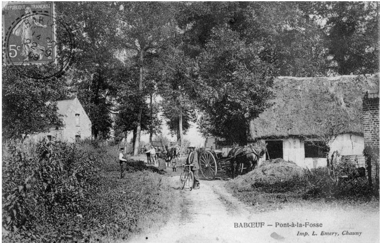
BABOEUF. Ferme repérée, Pont à la Fosse. Avant 1914 (AP).
