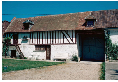
VILLE. Elévation antérieure de la grange d'une ferme repérée. Phot. Alain Nafilyan IVR22_19856001306ZA
