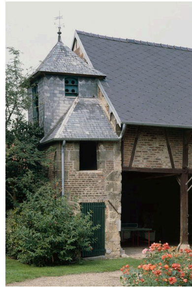
BABOEUF. Vue du pigeonnier d'une ferme repérée. Phot. Jean-Michel Périn IVR22_19846001052XA
