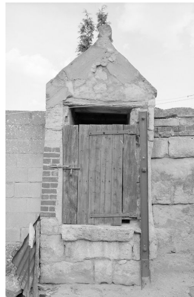
CUTS. Puits d'une ferme repérée. Phot. Jean-Michel Périn IVR22_19856000789X
