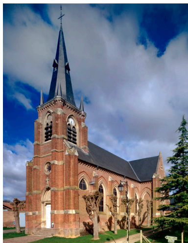
Façade antérieure et latérale est. Phot. Thierry Lefébure IVR22_19978000100VA
