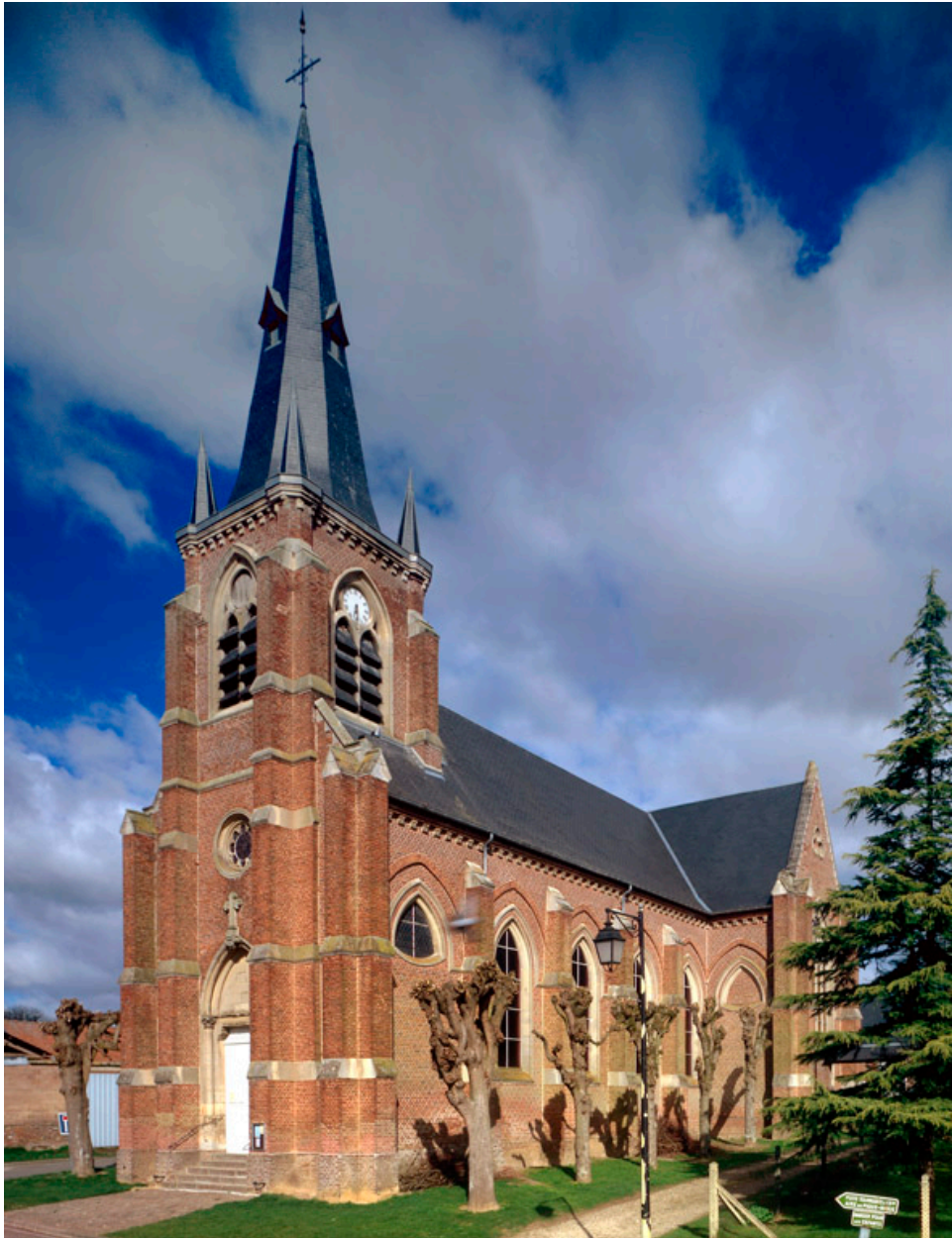
Façade antérieure et latérale est.
