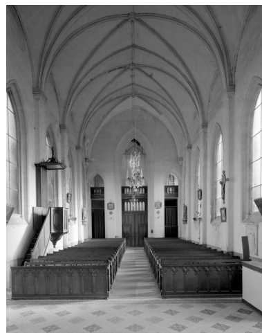
Vue intérieure, depuis le chœur. Phot. Thierry Lefébure IVR22_19978000040V
