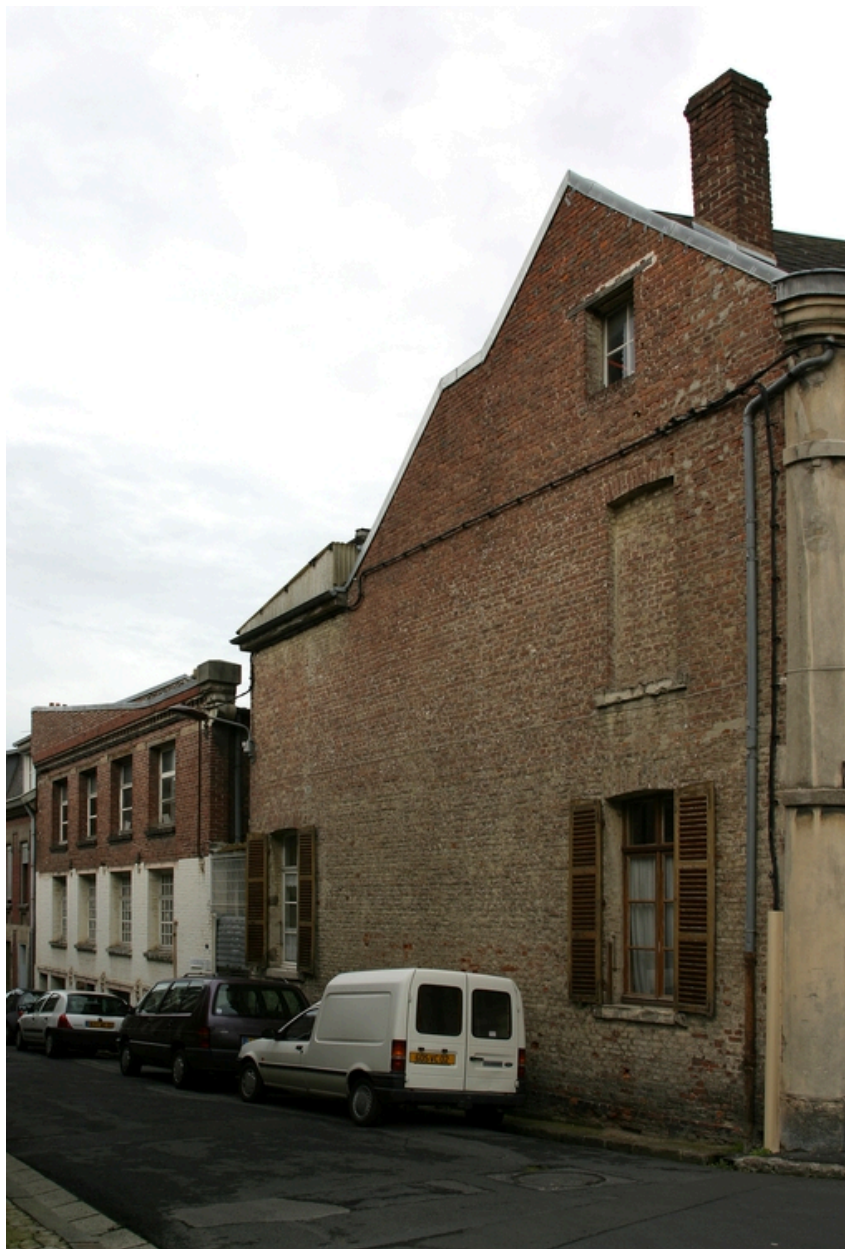
Façade antérieure des ateliers et pignon du logement patronal.
