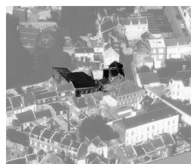
Vue aérienne du site en 1989. Phot. Pillet Frédéric, Autr. Phot'R IVR22_20050205742NUCA
