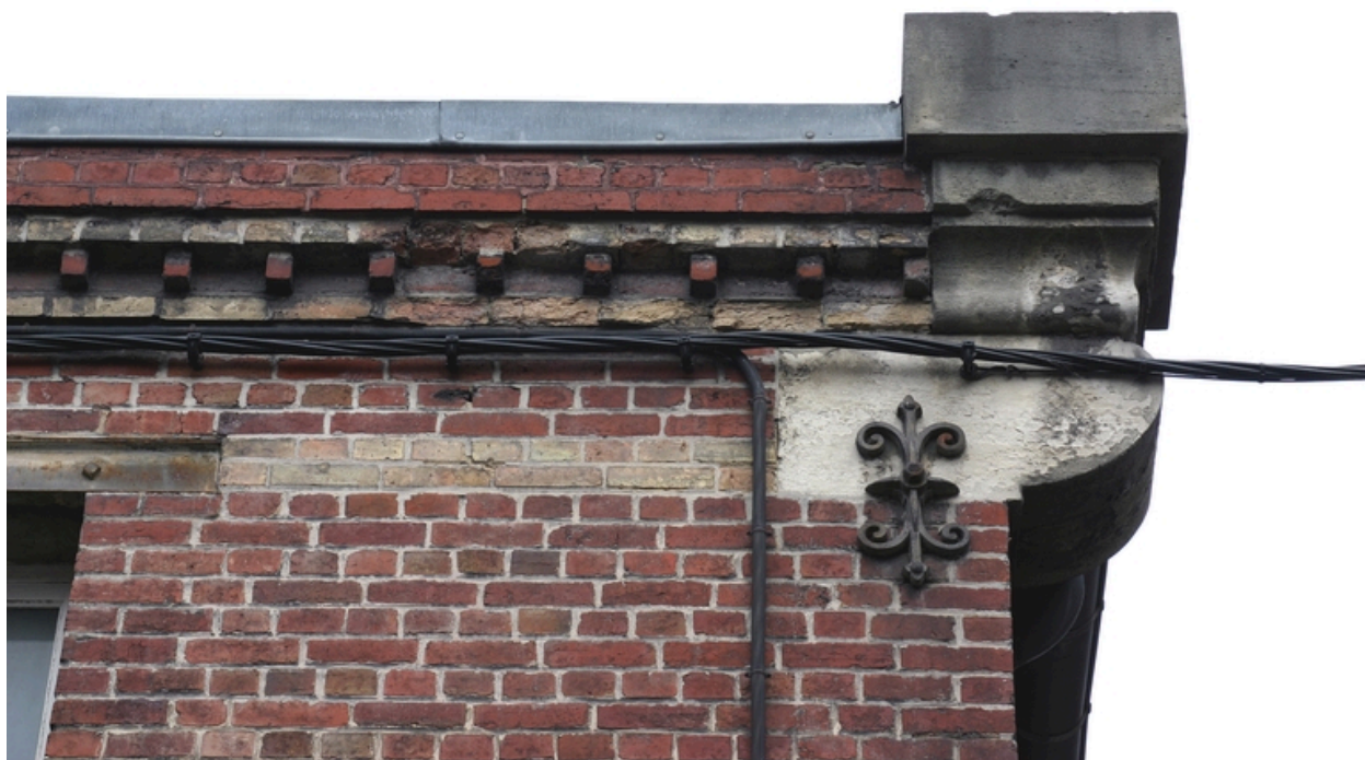
Façade antérieure des ateliers : détail.
