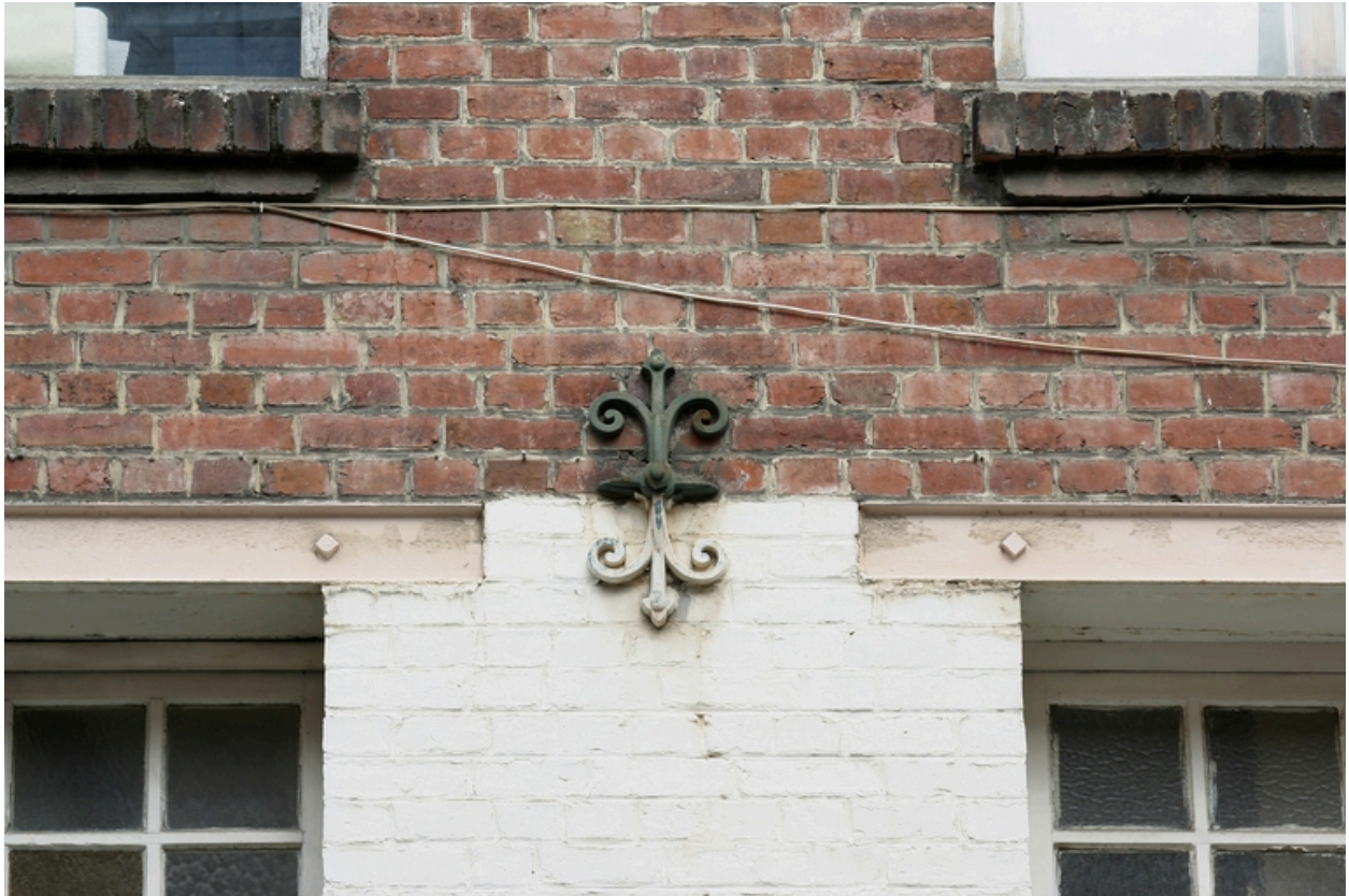
Façade antérieure des ateliers : détail.
