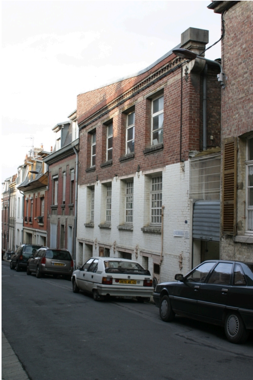
Façade antérieure des ateliers.
