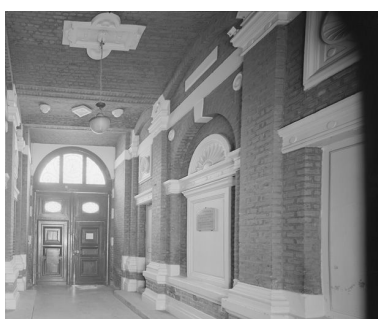
Ancienne entrée principale. Phot. Irwin Leullier IVR22_19978001003V
