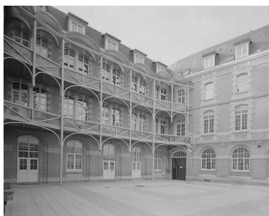
Cour intérieure et coursière de distribution. Phot. Irwin Leullier IVR22_19978001000V
