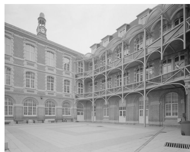
Cour intérieure et coursière de distribution. Phot. Irwin Leullier IVR22_19978001001V
