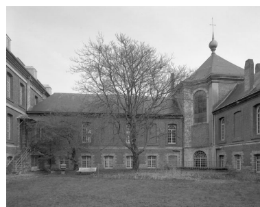
Bâtiment de plan en croix abritant les réfectoires des pensionnaires, la cuisine et la chapelle, vue générale montrant l'octogone central et l'une des ailes donnant sur le jardin occupant le quart antérieur gauche de la croix. Phot. Pierre Thibaut IVR31_20015900943V
