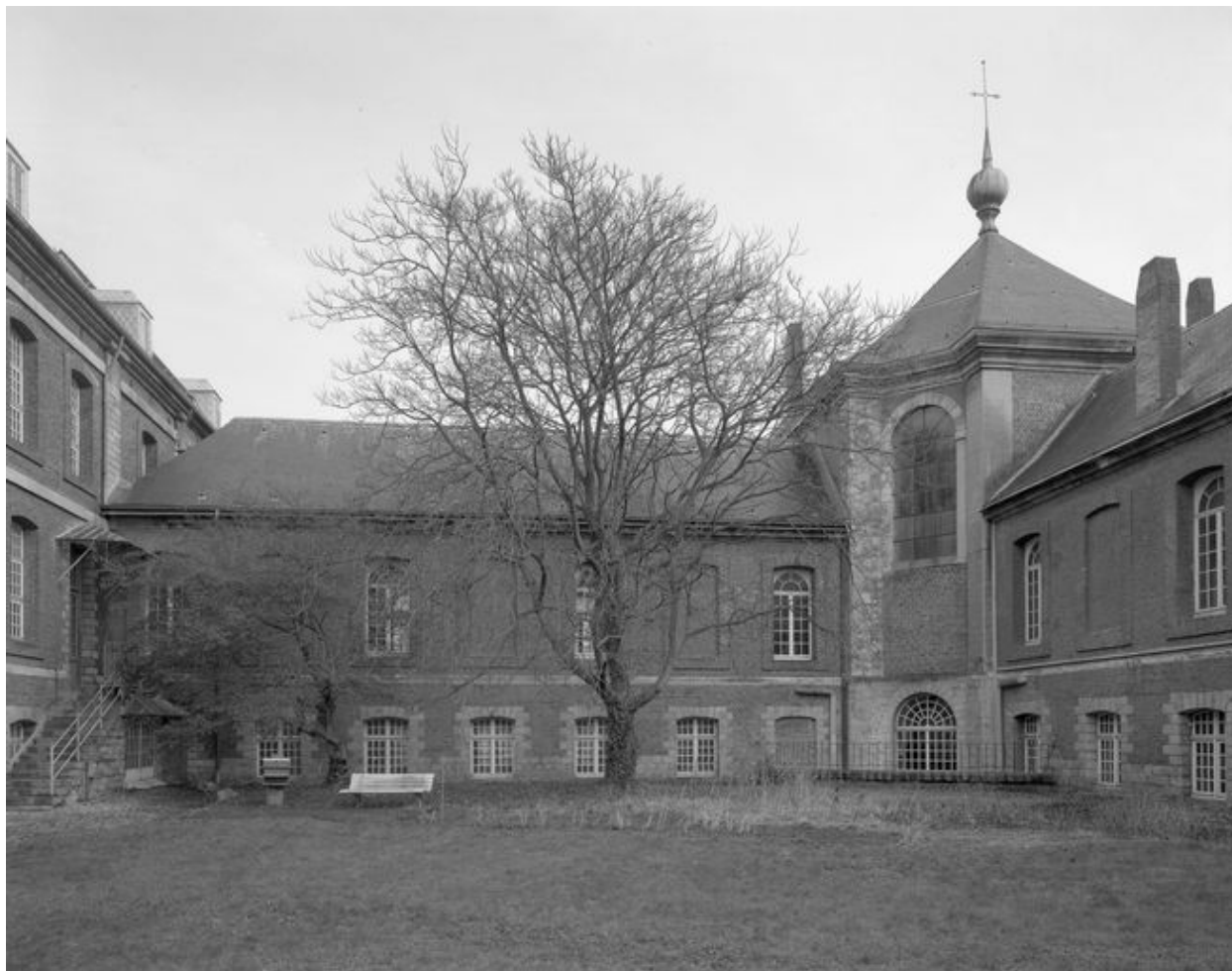
Bâtiment de plan en croix abritant les réfectoires des pensionnaires, la cuisine et la chapelle, vue générale montrant l'octogone central et l'une des ailes donnant sur le jardin occupant le quart antérieur gauche de la croix.
