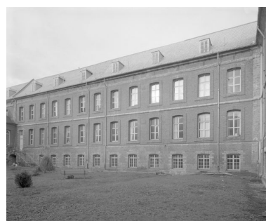
Bâtiments disposés en quadrilatère abritant les dortoirs des pensionnaires, vue montrant l'élévation d'un de ces bâtiments donnant sur le jardin occupant le quart postérieur gauche du quadrilatère. Phot. Pierre Thibaut IVR31_20015900951V
