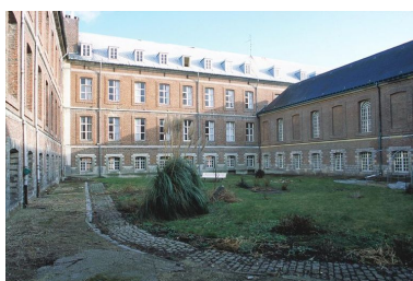
Bâtiments disposés en quadrilatère abritant les dortoirs des pensionnaires, vue montrant l'élévation de deux de ces bâtiments donnant sur le jardin occupant le quart postérieur gauche du quadrilatère. Phot. Pierre Thibaut IVR31_20015900220ZA
