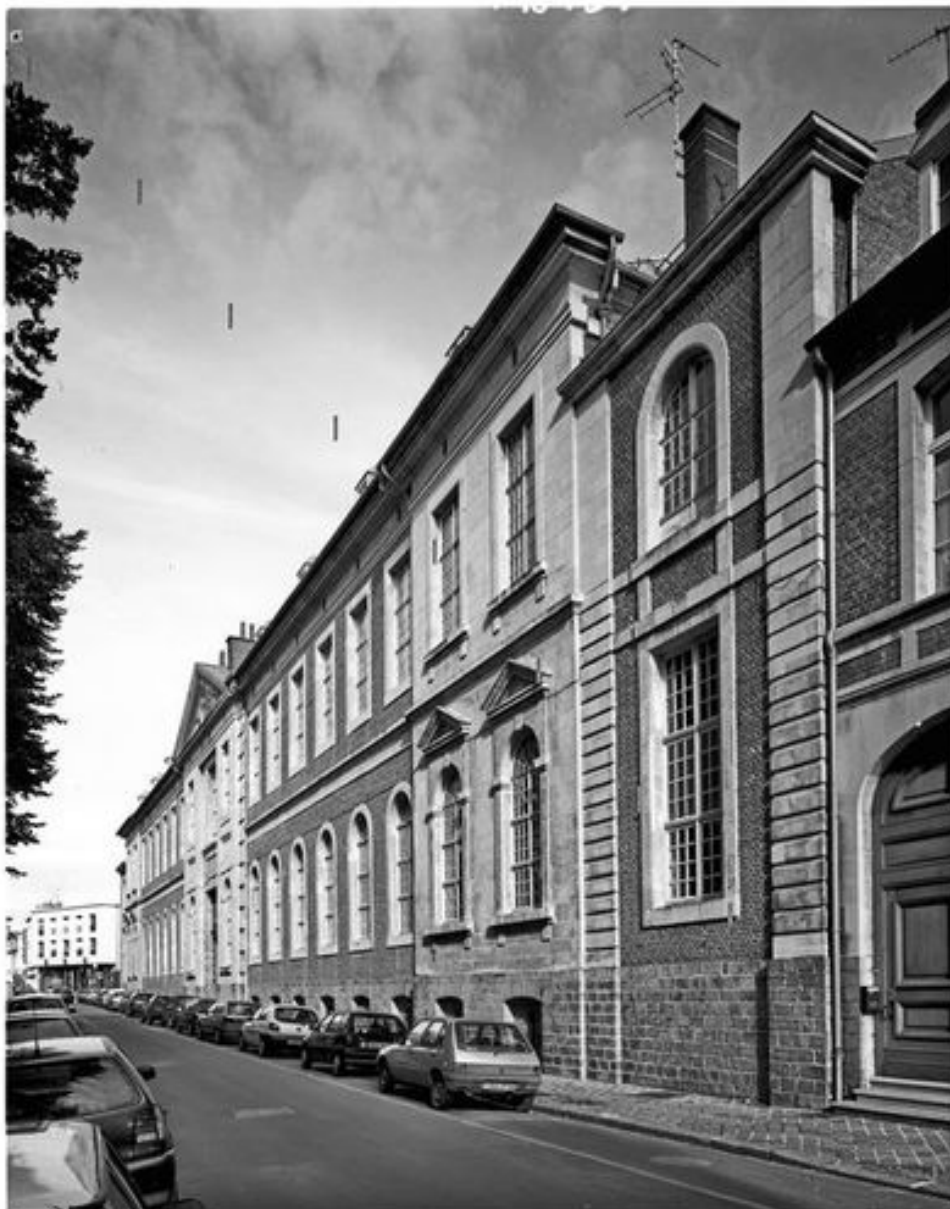
Bâtiment donnant sur la rue de Canteleu, destiné à abriter les infirmeries, élévation antérieure, vue générale prise de trois-quarts droit.
