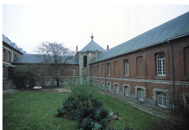
Bâtiment de plan en croix abritant les réfectoires des pensionnaires, la cuisine et la chapelle, vue générale des deux ailes délimitant le jardin occupant le quart antérieur gauche de la croix. Phot. Pierre Thibaut IVR31_20015900221ZA
