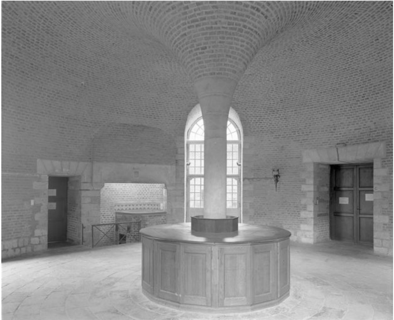
Bâtiment de plan en croix abritant les réfectoires des pensionnaires, la cuisine et la chapelle, rez-de-chaussée, ancienne cuisine, vue générale avec, dans l'axe, l'une des fenêtres, et sur la gauche, le puits.
