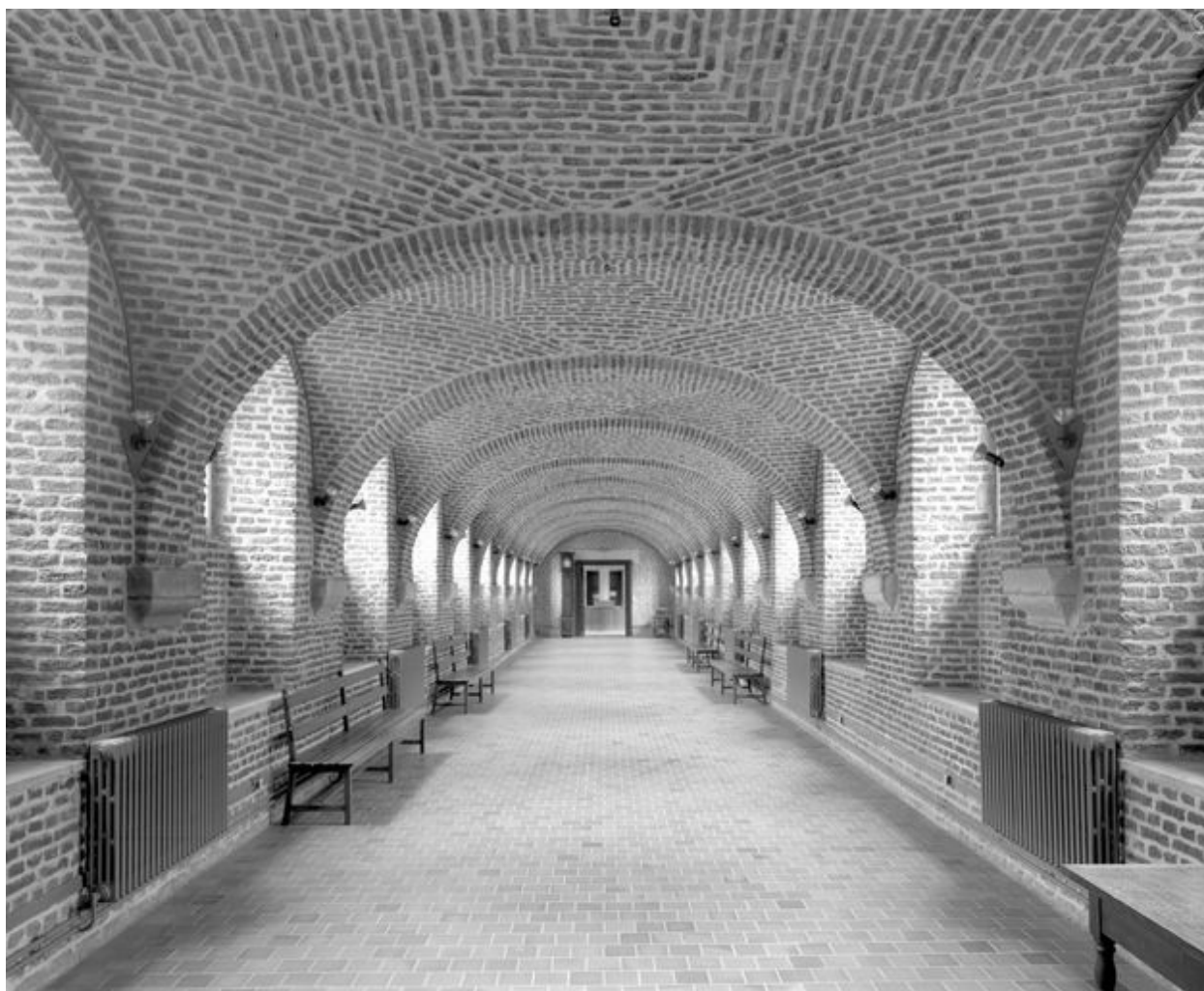
Bâtiment de plan en croix abritant les réfectoires des pensionnaires, la cuisine et la chapelle, rez-de-chaussée, enfilade d'un des quatre réfectoires, vue générale en regardant vers l'ancienne cuisine.
