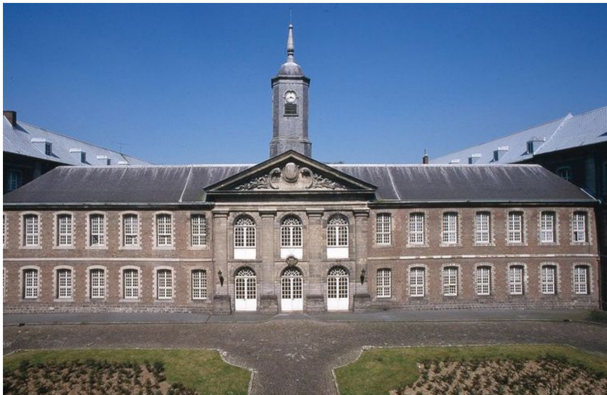
Bâtiment régissant sur tout le fond de la cour d'honneur, élévation antérieure, vue générale.
