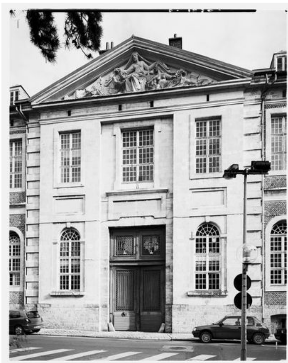
Bâtiment donnant sur la rue de Canteleu, destiné à abriter les infirmeries, élévation antérieure, avant-corps central, vue générale prise de face.
