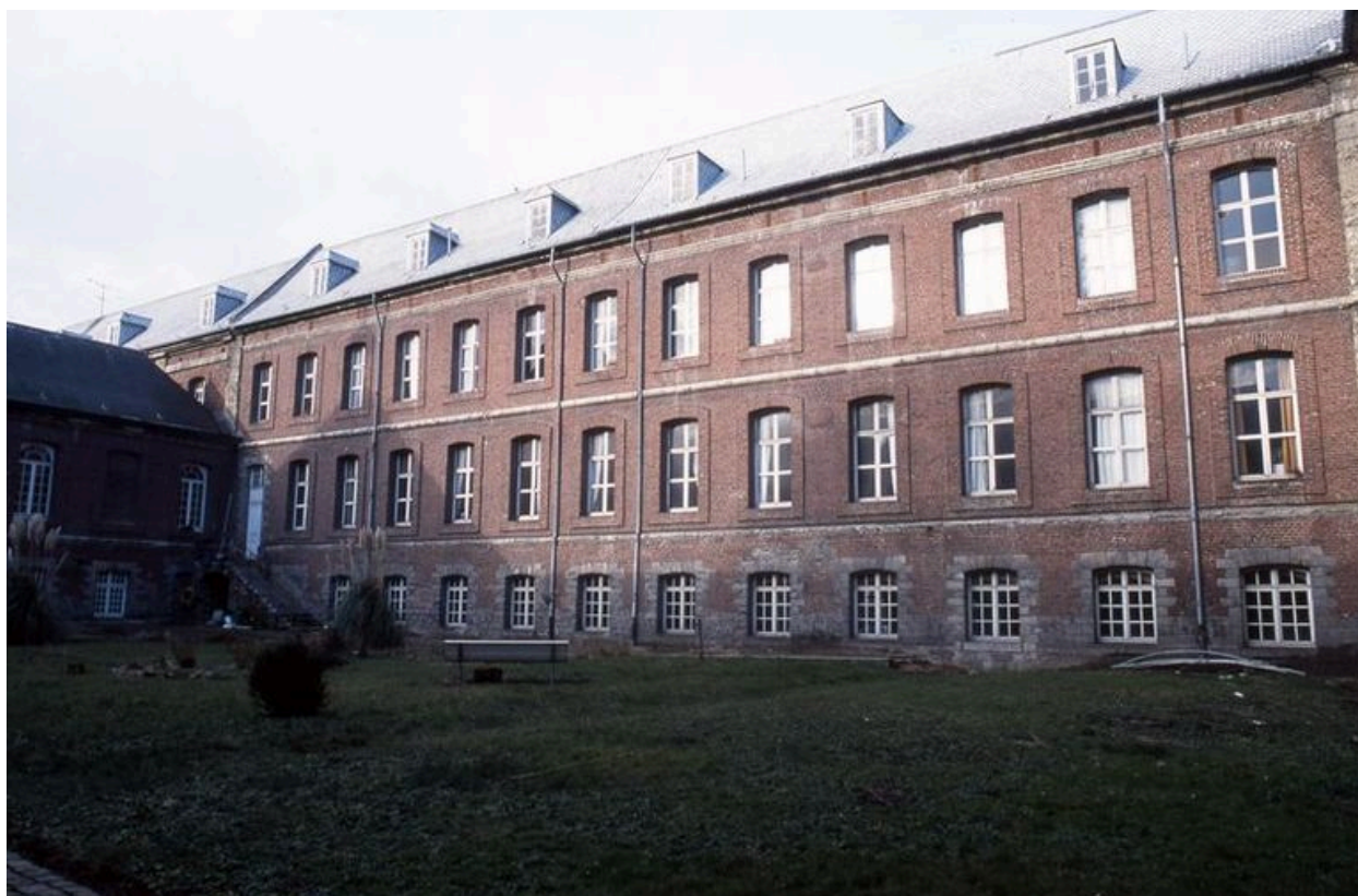
Bâtiments disposés en quadrilatère abritant les dortoirs des pensionnaires, vue montrant l'élévation d'un de ces bâtiments donnant sur le jardin occupant le quart postérieur gauche du quadrilatère.
