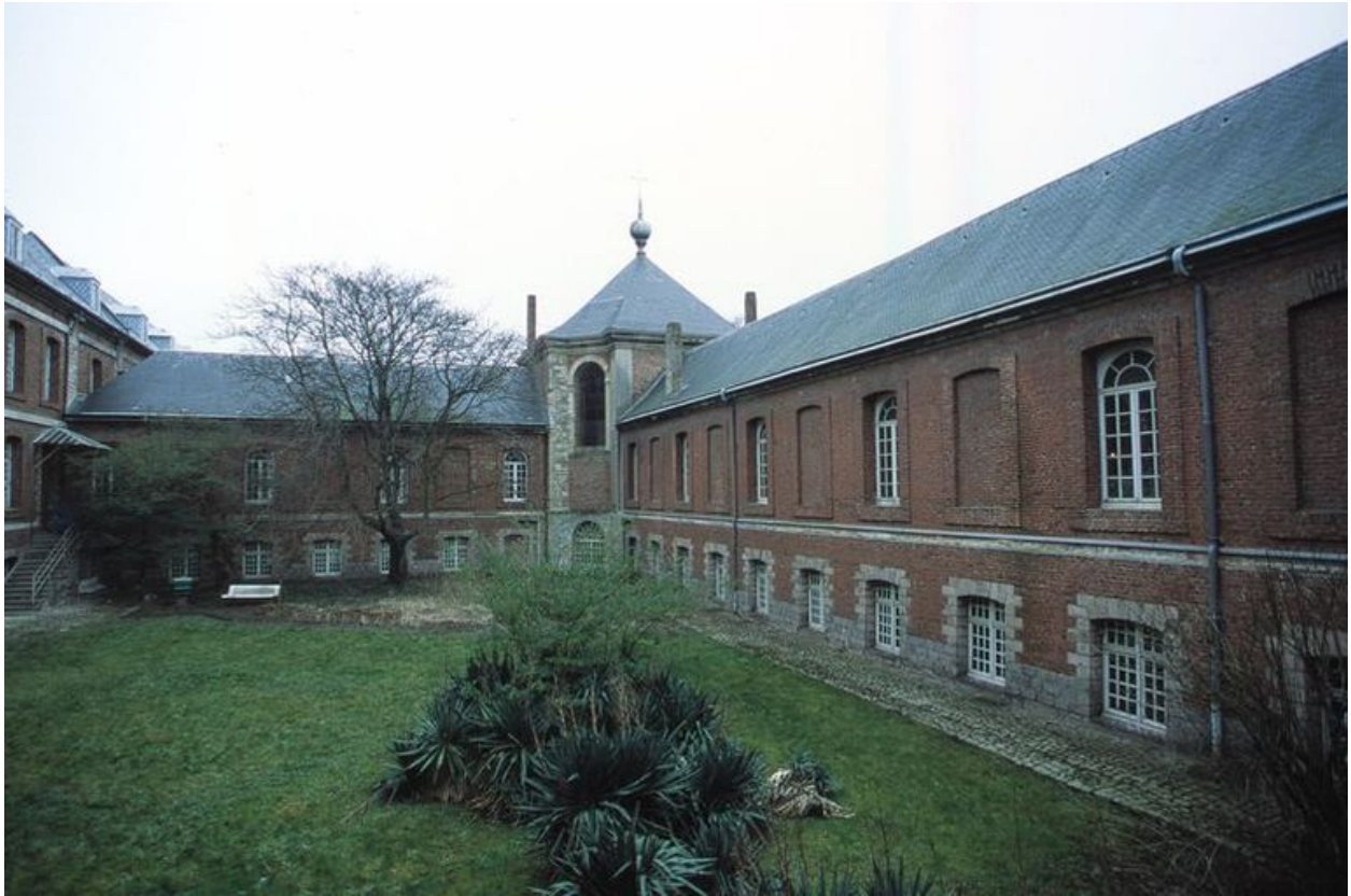
Bâtiment de plan en croix abritant les réfectoires des pensionnaires, la cuisine et la chapelle, vue générale des deux ailes délimitant le jardin occupant le quart antérieur gauche de la croix.
