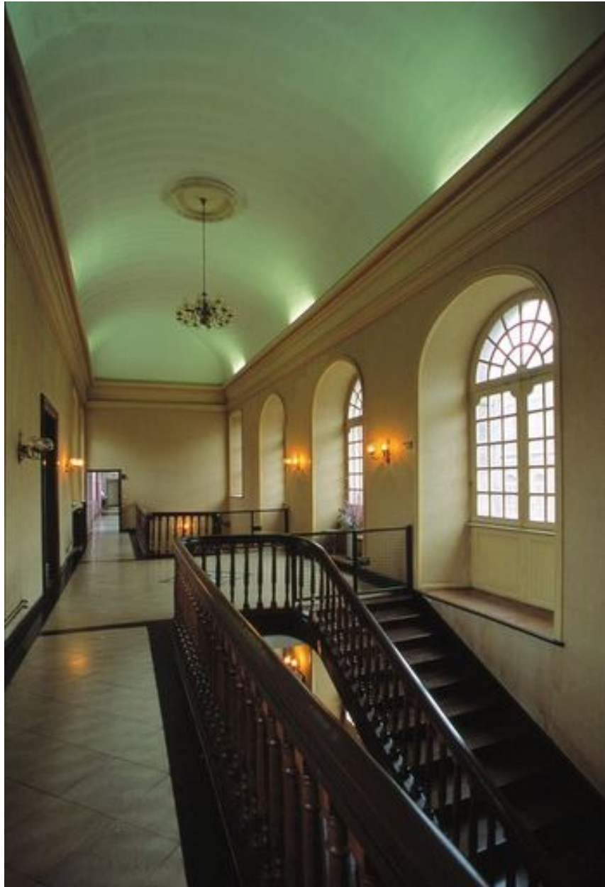
Bâtiment régissant sur tout le fond de la cour d'honneur, premier étage, escalier d'honneur, palier, vue en enfilade montrant la montée gauche de la 2e volée double.
