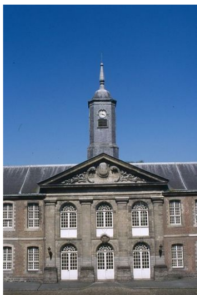
Bâtiment régnant sur tout le fond de la cour d'honneur, élévation antérieure, avant-corps central, vue générale. Phot. Pierre-Louis Laget IVR31_20015901248ZA
