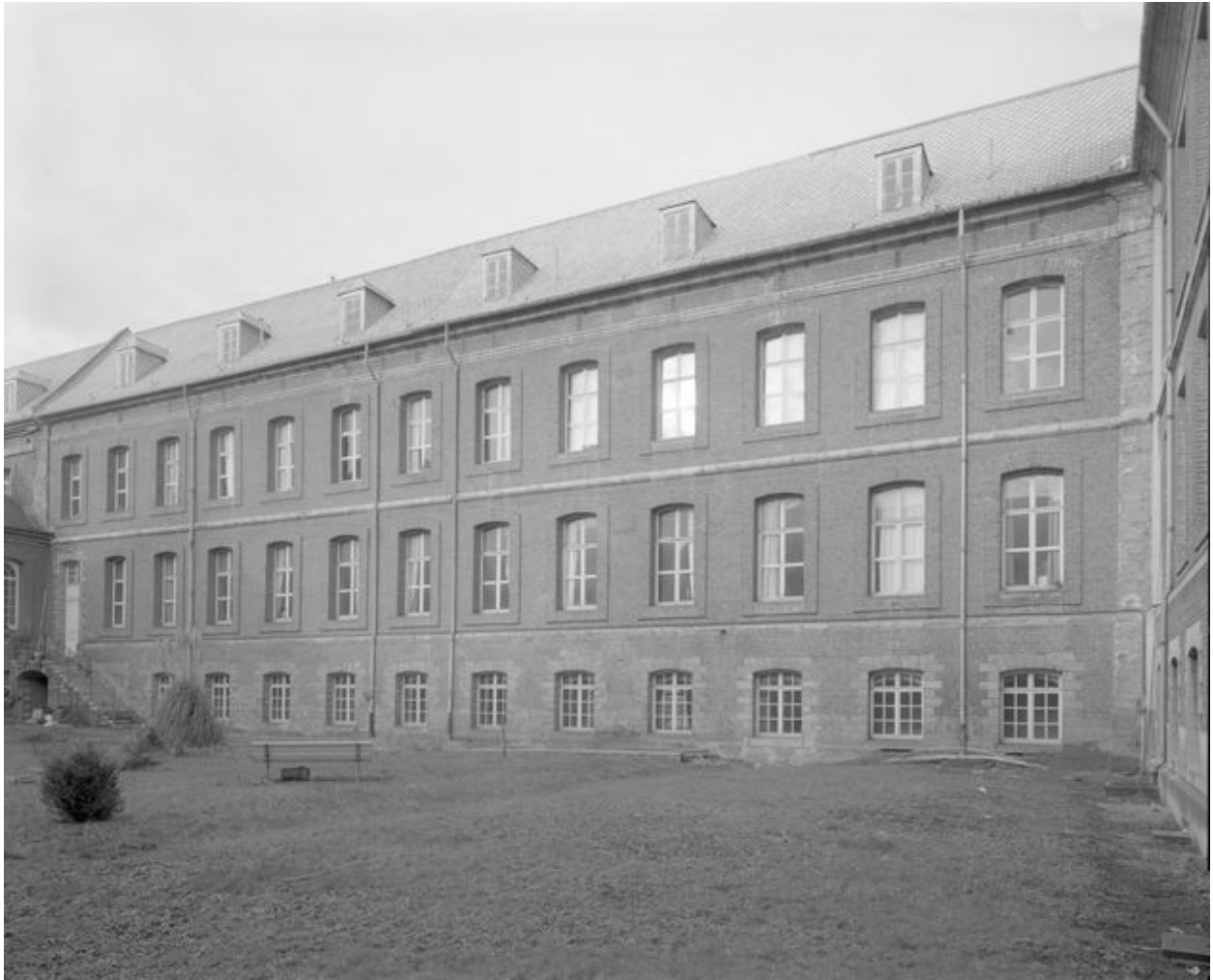
Bâtiments disposés en quadrilatère abritant les dortoirs des pensionnaires, vue montrant l'élévation d'un de ces bâtiments donnant sur le jardin occupant le quart postérieur gauche du quadrilatère.
