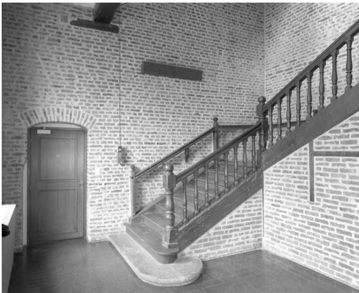
Bâtiments disposés en quadrilatère abritant les dortoirs des pensionnaires, rez-de-chaussée, départ d'un escalier.
