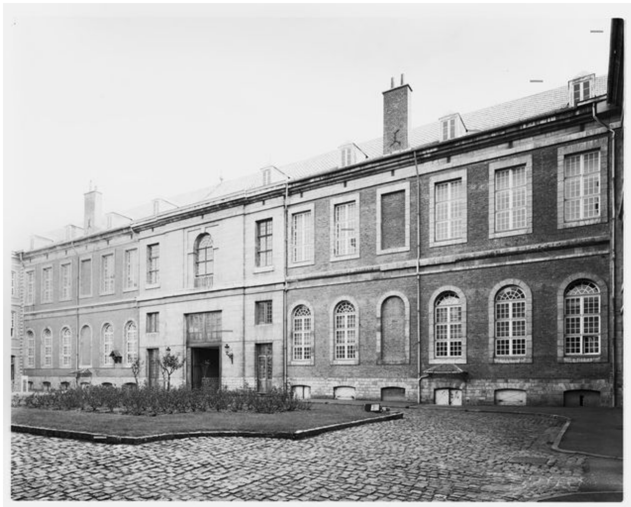
Bâtiment donnant sur la rue de Canteleu, destiné à abriter les infirmeries, élévation postérieure régnant sur l'avant de la cour d'honneur, vue générale prise de trois-quarts droit.
