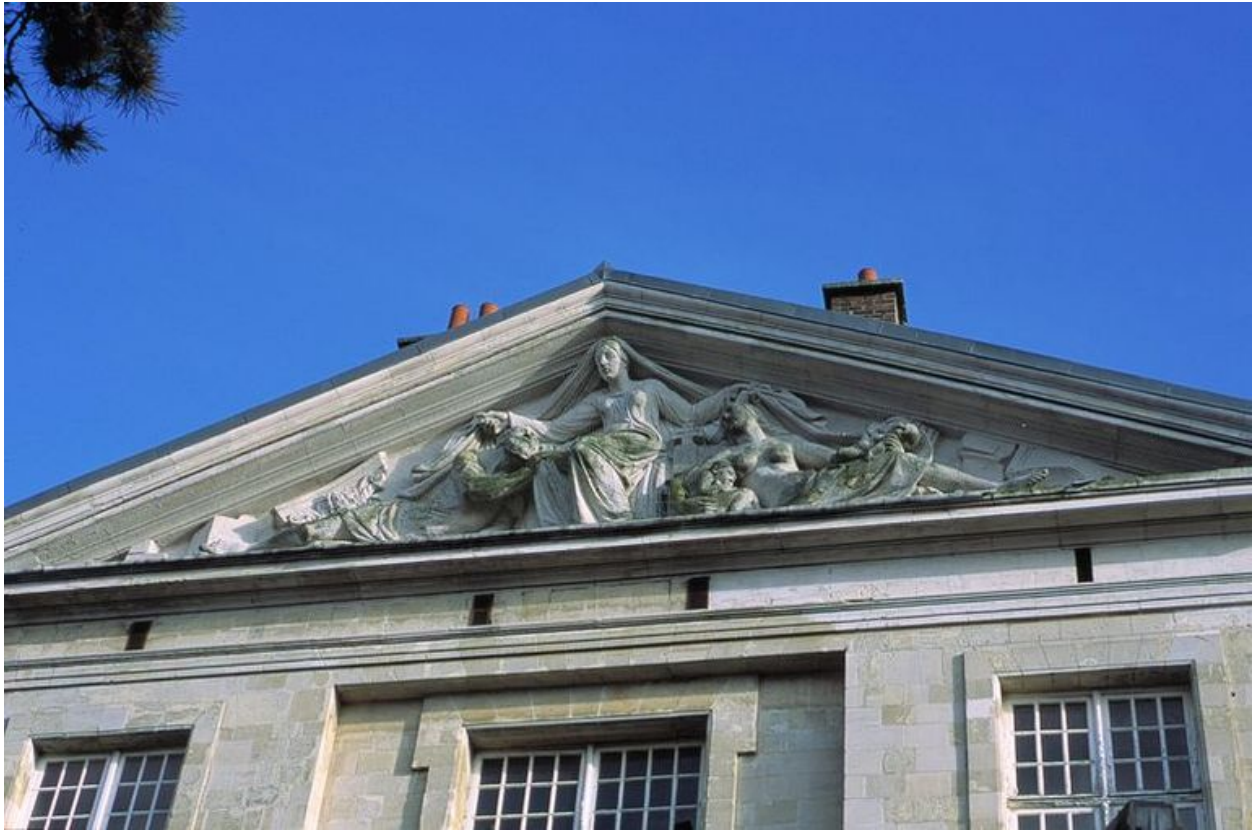
Bâtiment donnant sur la rue de Canteleu, destiné à abriter les infirmeries, élévation antérieure, avant-corps central, détail du fronton.
