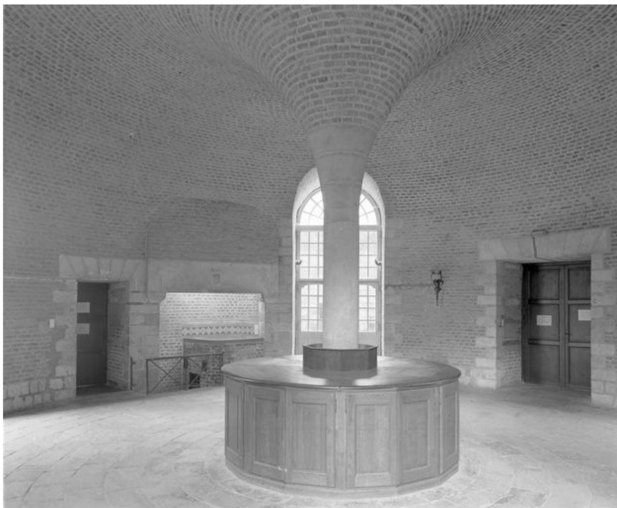
Bâtiment de plan en croix abritant les réfectoires des pensionnaires, la cuisine et la chapelle, rez-de-chaussée, ancienne cuisine, vue générale avec, dans l'axe, l'une des fenêtres, et sur la gauche, le puits.
