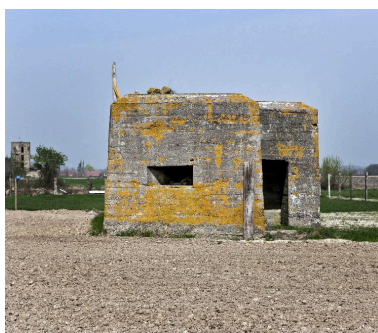
Elévation sud et le porche pare-suffle Phot. Jean-Marc Ramette IVR31_20145904433NUCA
