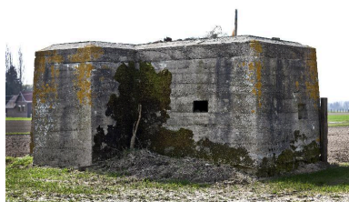
Vue vers le sud-ouest Phot. Jean-Marc Ramette IVR31_20145904437NUCA
