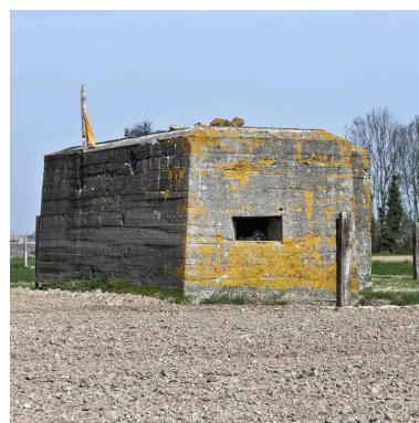
Elévations ouest et sud Phot. Jean-Marc Ramette IVR31_20145904434NUCA
