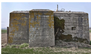
Vue vers l'ouest. Au premier plan le porche pare-suffle Phot. Jean-Marc Ramette IVR31_20145904436NUCA
