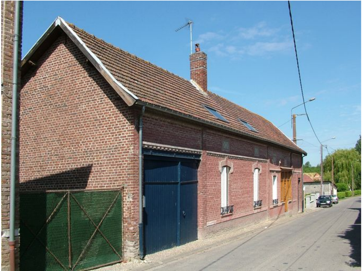
Maison, 7 rue du Marais, présentant la devanture d'une ancienne boutique, années 1920-1930.
