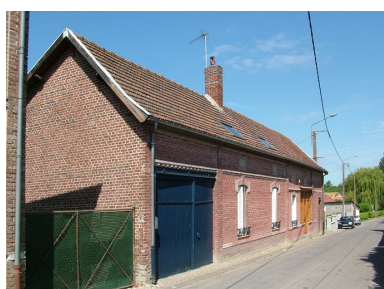
Maison, 7 rue du Marais, présentant la devanture d'une ancienne boutique, années 1920-1930. Phot. Frédéric Fournis IVR22_20098005225NUCA
