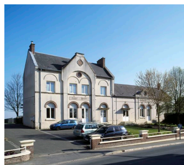
La mairie de Bettencourt-Saint-Ouen (ancienne école et mairie). Phot. Marie-Laure Monnehay-Vulliet IVR22_20108000144XA
