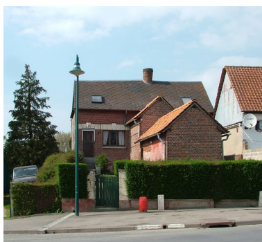
Ancienne ferme 13, rue Principale, construite au 19e siècle et partagée au 20e siècle en deux habitats distinct. Phot. Frédéric Fournis IVR22_20098005223NUCA
