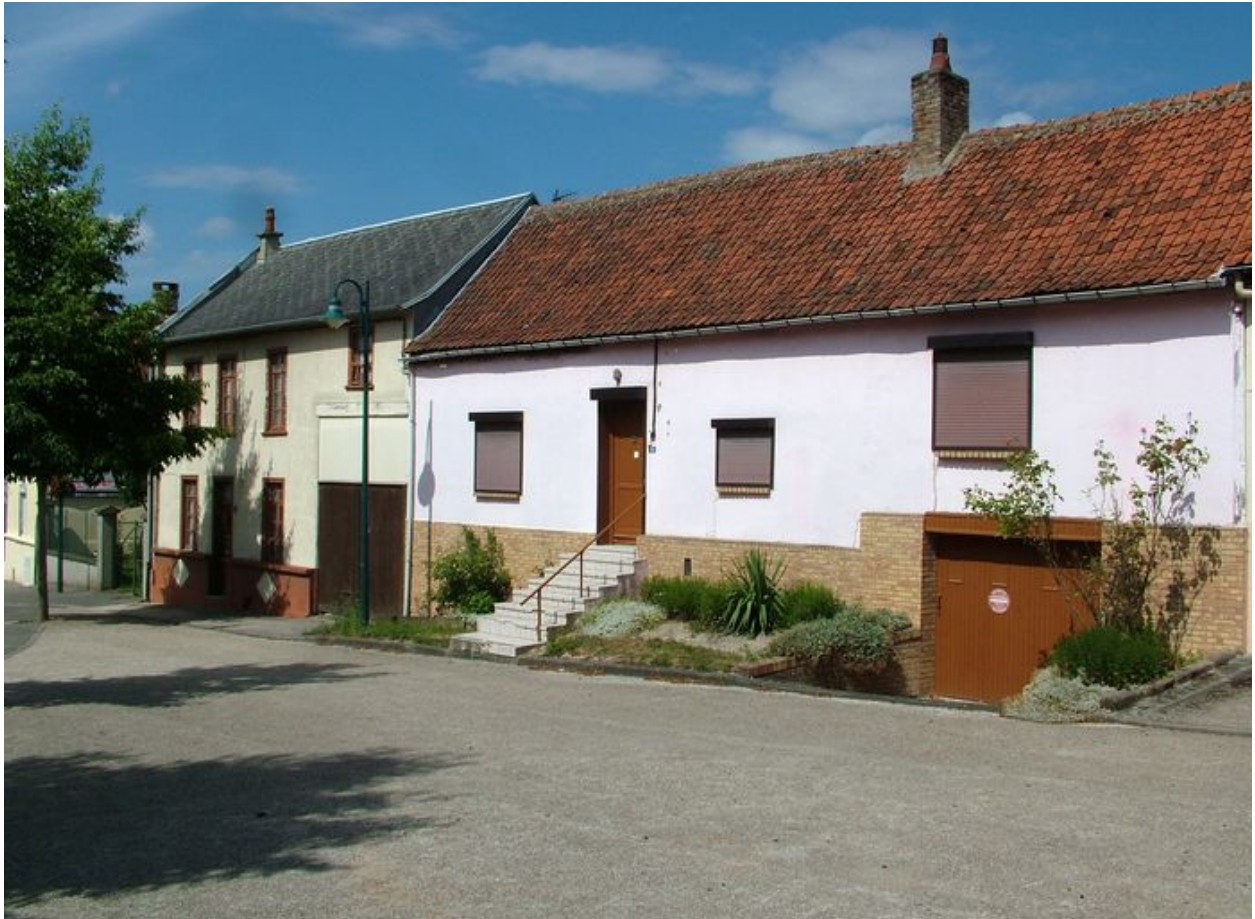
Maisons, 29 et 31 rue Principale, 19e siècle.
