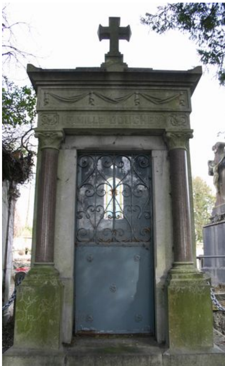
Vue rapprochée de la façade principale.
