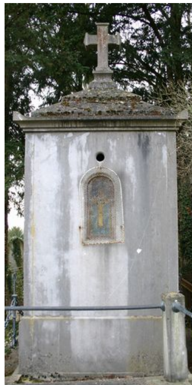
Vue rapprochée de la façade postérieure. Phot. Caroline Vincent IVR22_20078000520NUCA
