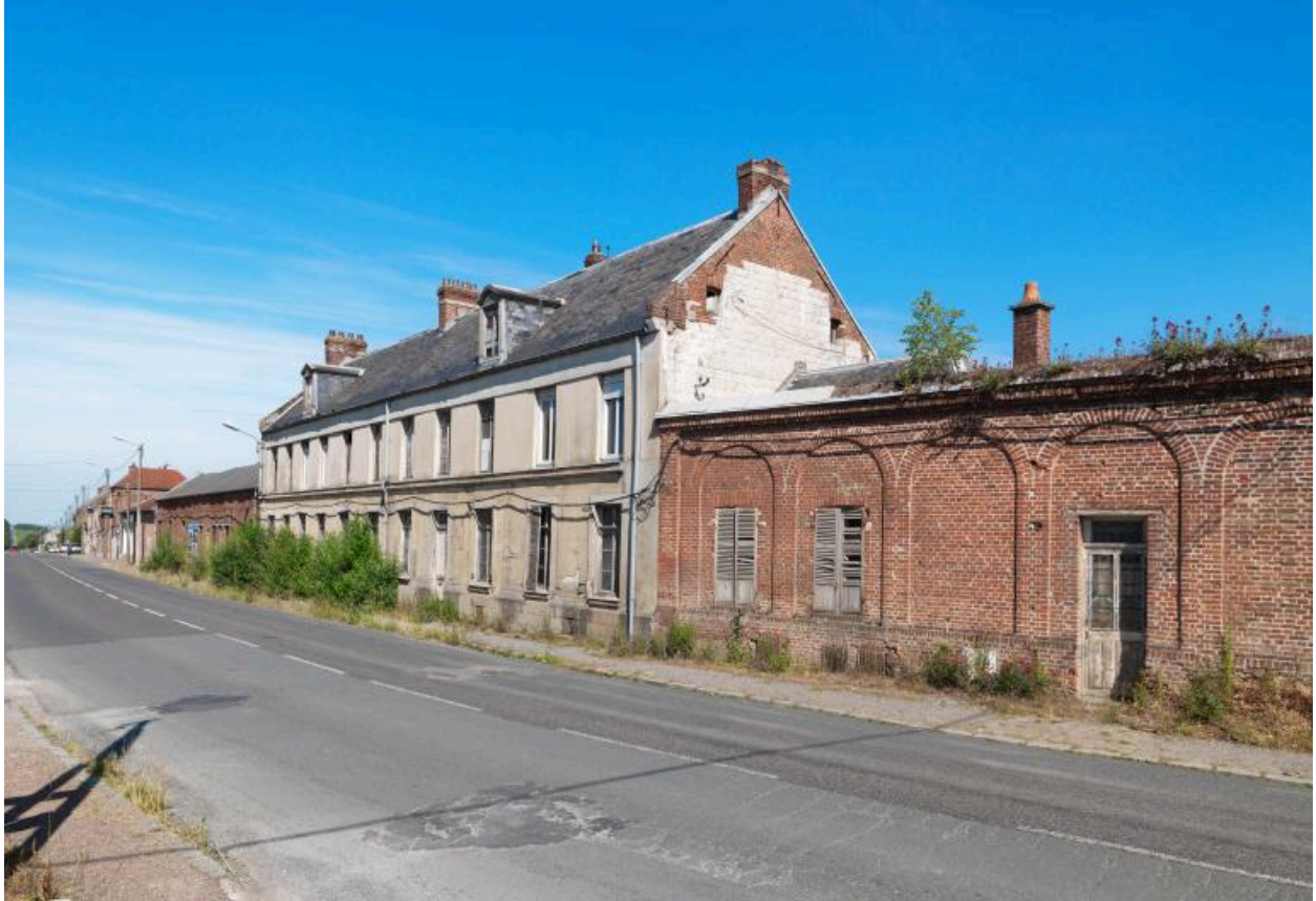
Vue des façades sur la route d'Amiens.
