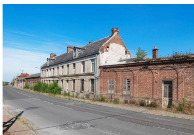
Vue des façades sur la route d'Amiens.
