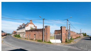
Vue de situation depuis le sud-est, dans l'axe du portail.
