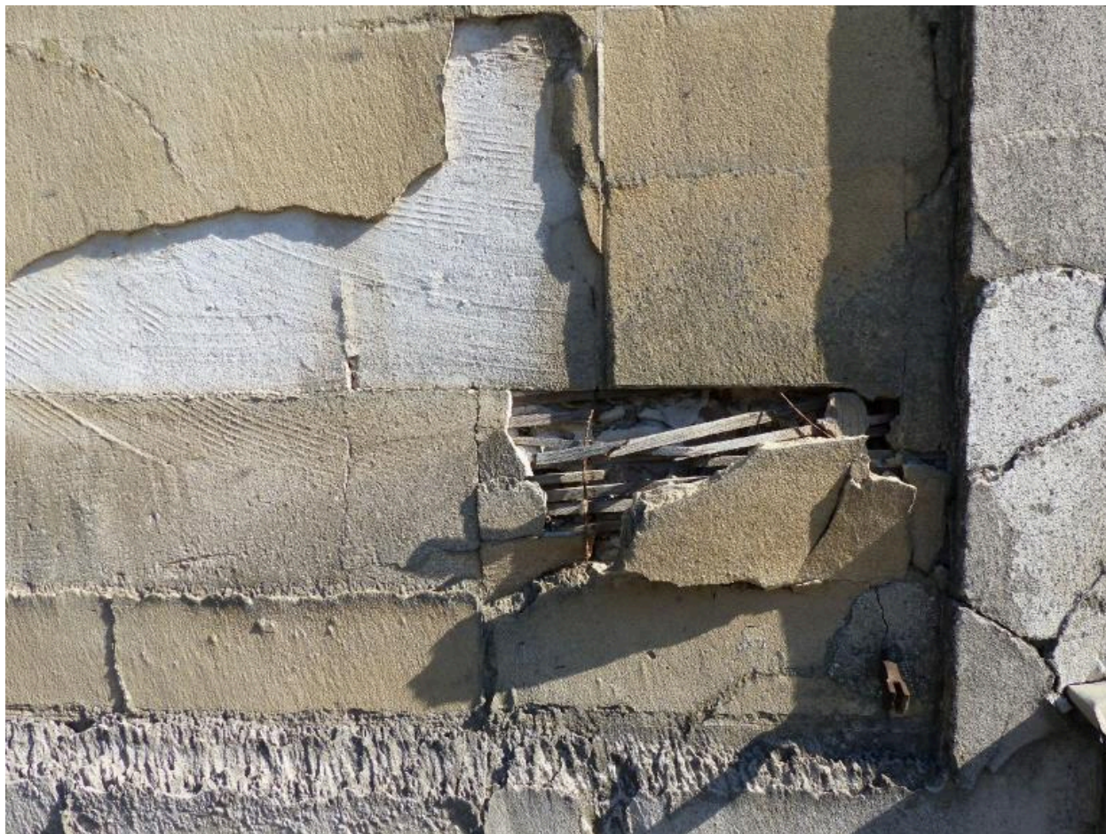
Vue de détail sur le lattis présent sous l'enduit.
