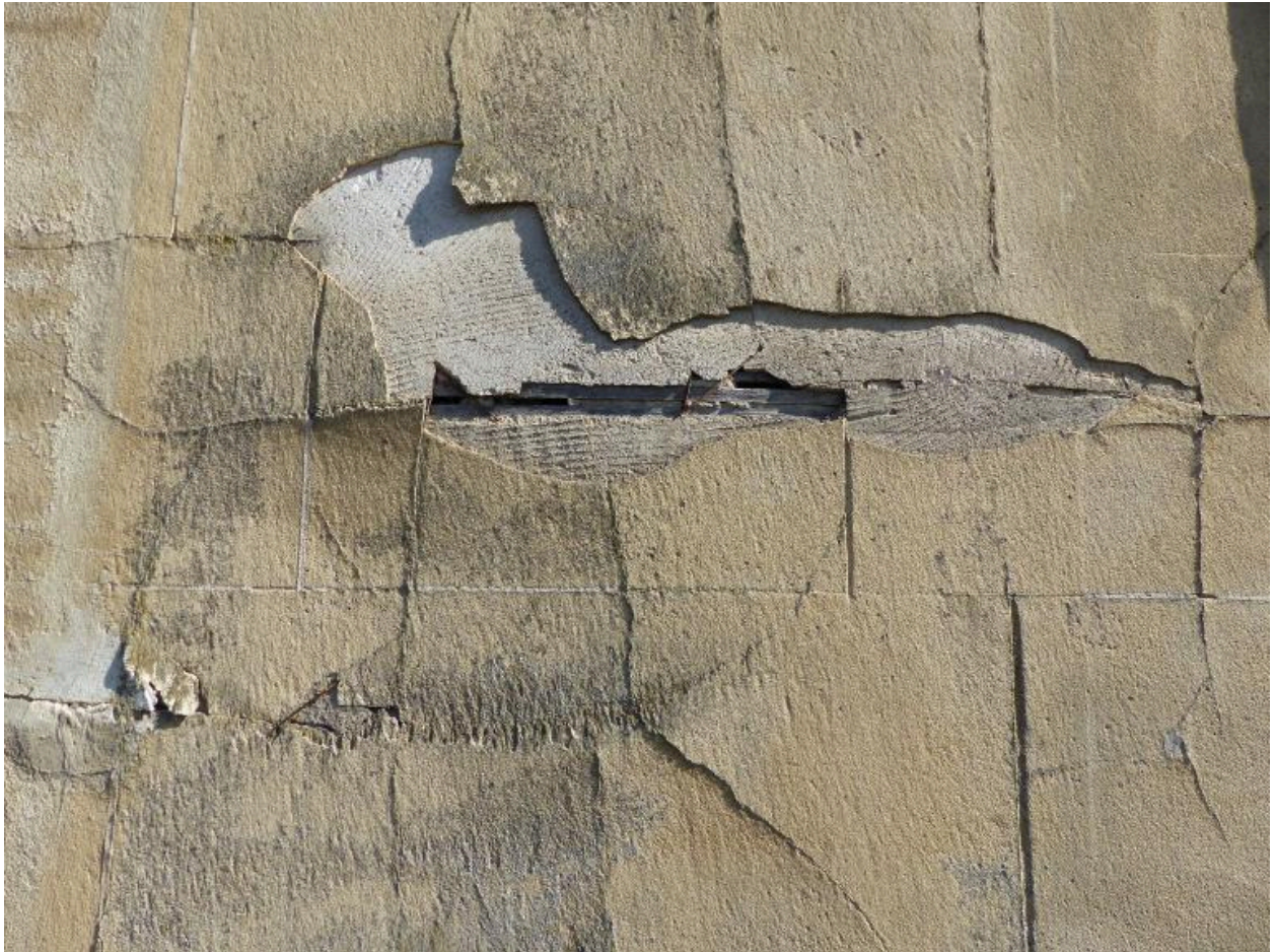
Vue de détail sur l'enduit fausse pierre de taille et le lattis.
