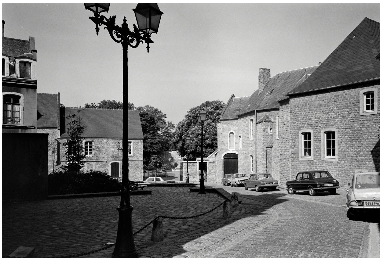
Vue générale sur la rue Guyale.
