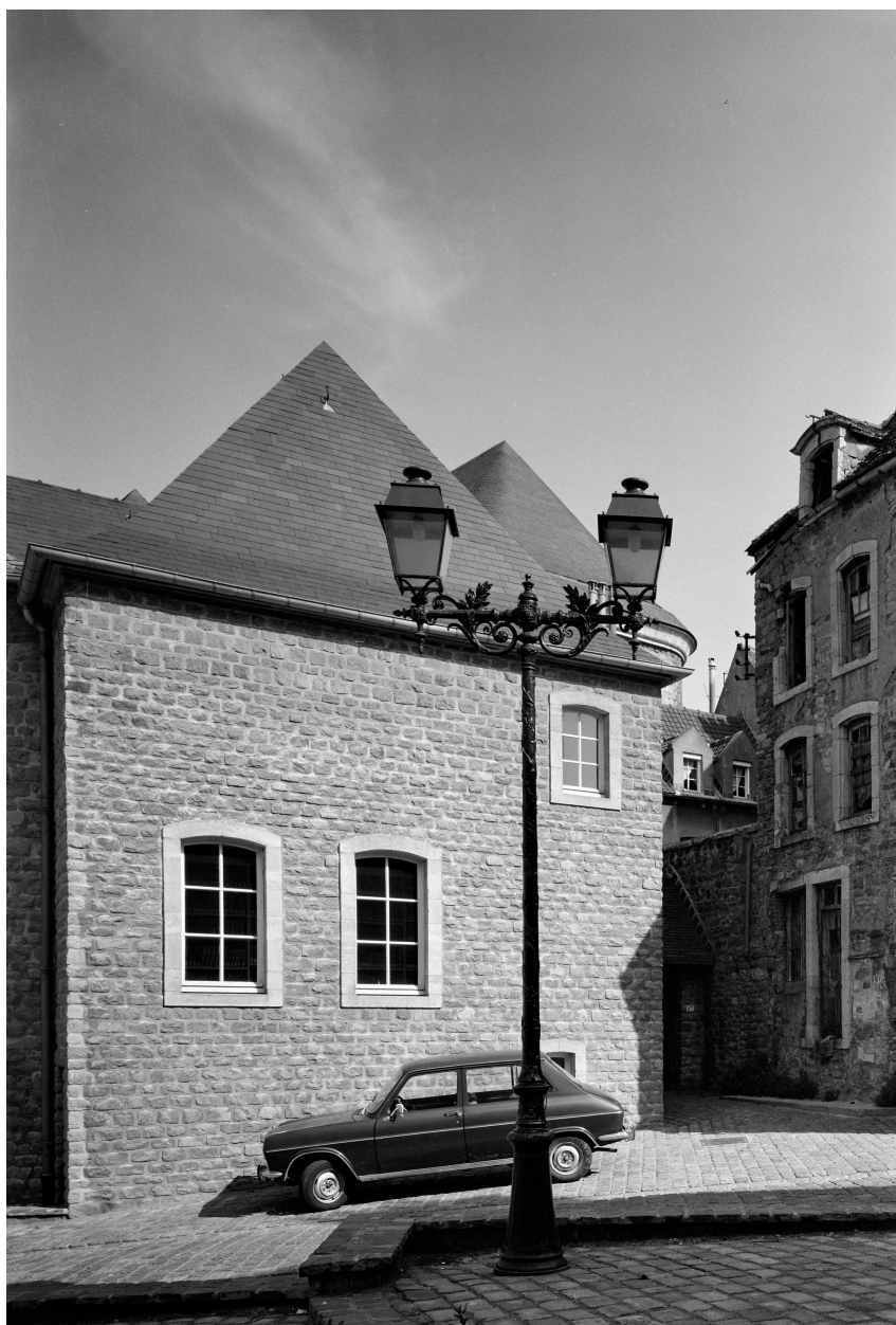
Façade partielle rue Guyale, détail.
