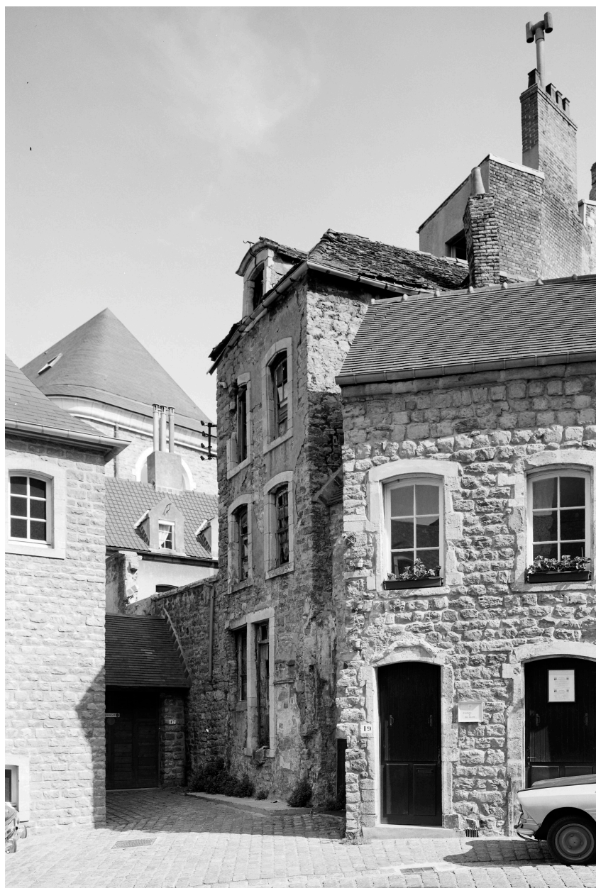
Façade sur Guyale, chevet de l'église, détail.
