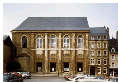
Façade sur place. Phot. Jean-Michel Périn IVR31_19876201423XA
