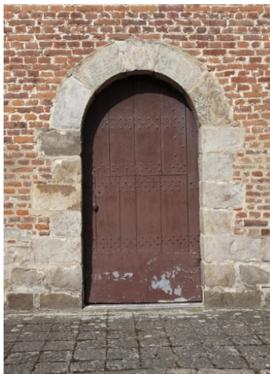
Détail de la porte du premier logis. Phot. Pierre Thibaut IVR31_20095903263NUCA
