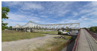
Vue générale depuis le sud. Phot. Thierry Lefébure IVR32_20170200171NUC2AQ
