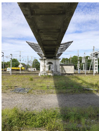
Dessous du tablier de la passerelle. Phot. Thierry Lefébure IVR32_20170200174NUC2A
