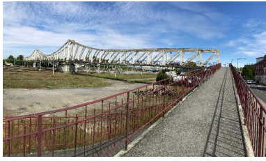
Rampe d'accès piéton à la passerelle. Phot. Bertrand Fournier IVR32_20170205225NUC2A
