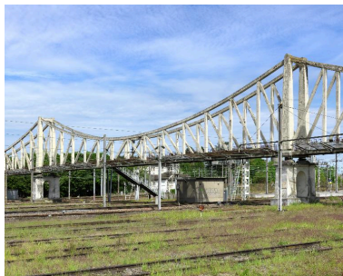
Vue du tablier central de la passerelle. Phot. Thierry Lefébure IVR32_20170200172NUC2A
