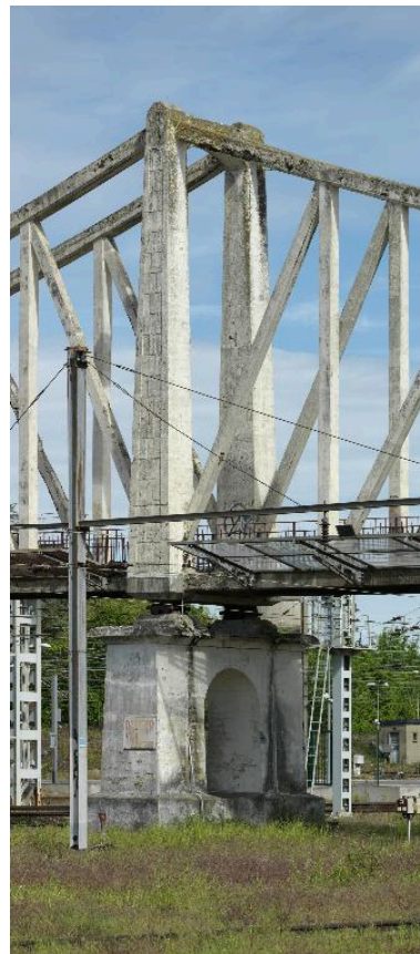
Détail d'un support de la passerelle. Phot. Thierry Lefébure IVR32_20170200173NUC2AQ
