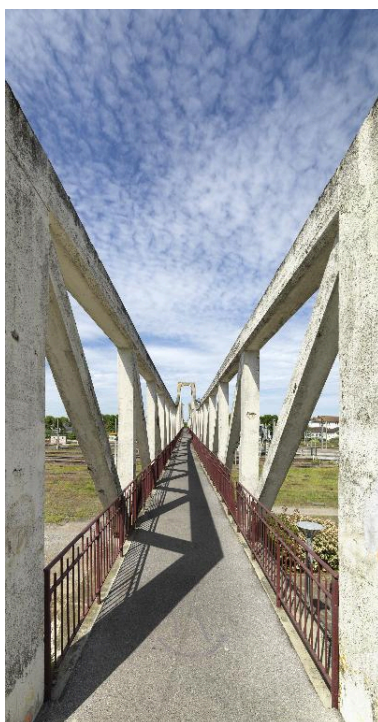
Vue générale depuis la passerelle. Phot. Thierry Lefébure IVR32_20170200175NUC2AQ
