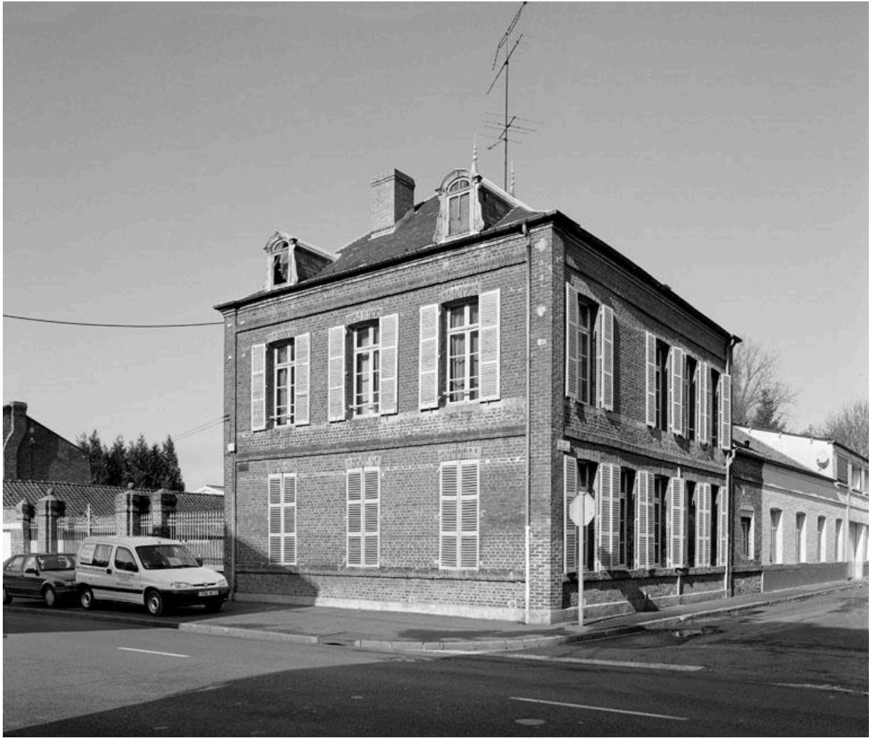
Vue de la maison et des bâtiments professionnels, en prolongement sur la rue du Moulin-Neuf.
