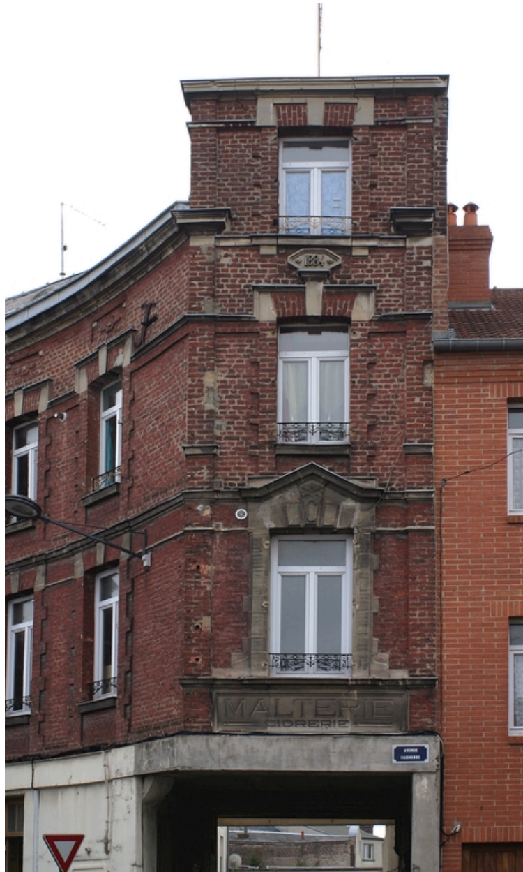
Façade antérieure des logements d'employés.
