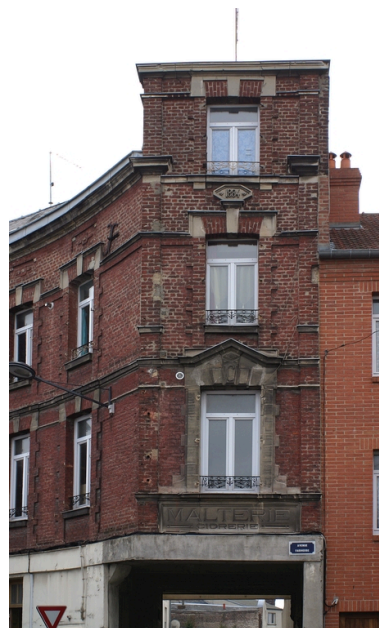
Façade antérieure des logements d'employés.
