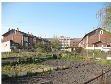
Vue générale des deux barres de logements ouvriers (48 habitations). Phot. Clarisse Lorieux IVR22_20086005128NUCA
