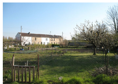
Barre de logements ouvriers construits en pierre. Phot. Clarisse Lorieux IVR22_20086005137NUCA
