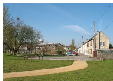
A droite : barre de 5 logements ouvriers en pierre, au centre le château d'eau de l'usine et à gauche un des barres de logements ouvriers en brique. Phot. Clarisse Lorieux IVR22_20086005135NUCA
