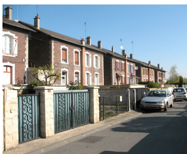
Barre de logements ouvriers de la cité Mertian. Phot. Clarisse Lorieux IVR22_20086005134NUCA
