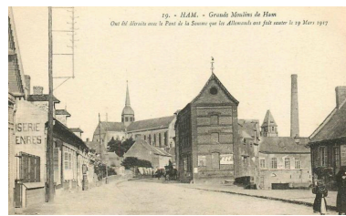
Les grands moulins de Ham avant leur destruction en 1917 (coll. part.). Phot. Fournier Bertrand (reproduction) IVR32_20168005001NUCA
