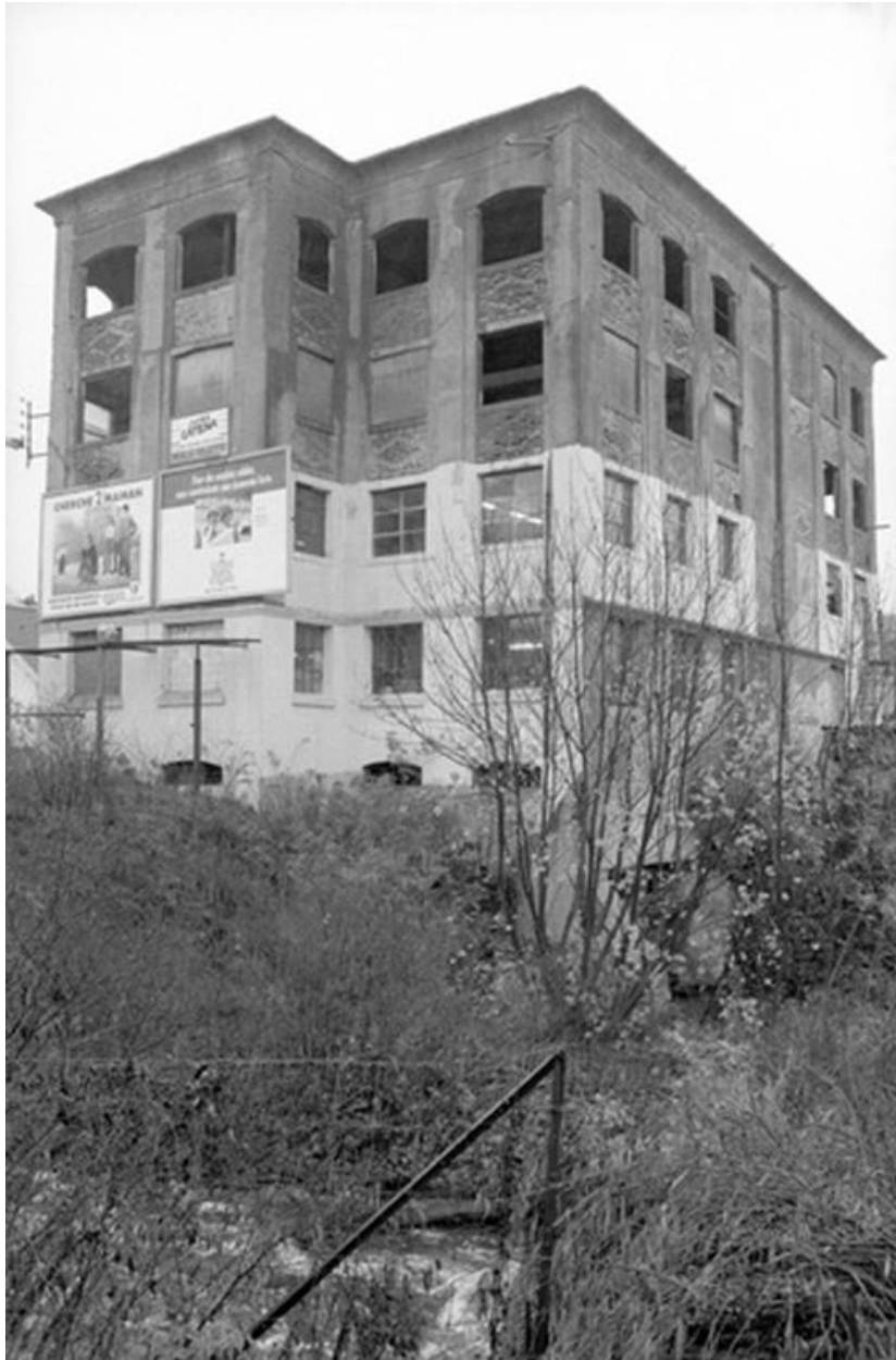
Vue d'ensemble, flanc nord ouest.
