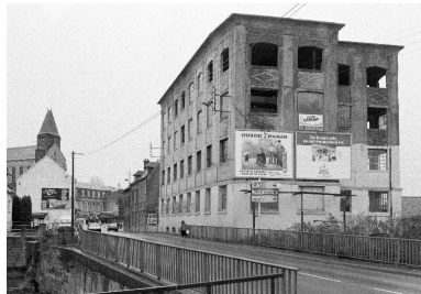
Vue d'ensemble de la minoterie en 1990. Phot. Francis Dubuc IVR22_19908001365Z
