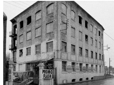
Vue de la minoterie en 1990, façade sur rue Phot. Francis Dubuc IVR22_19908001369Z
