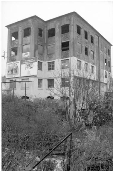
Vue d'ensemble, flanc nord ouest. Phot. Francis Dubuc IVR22_19908001366Z
