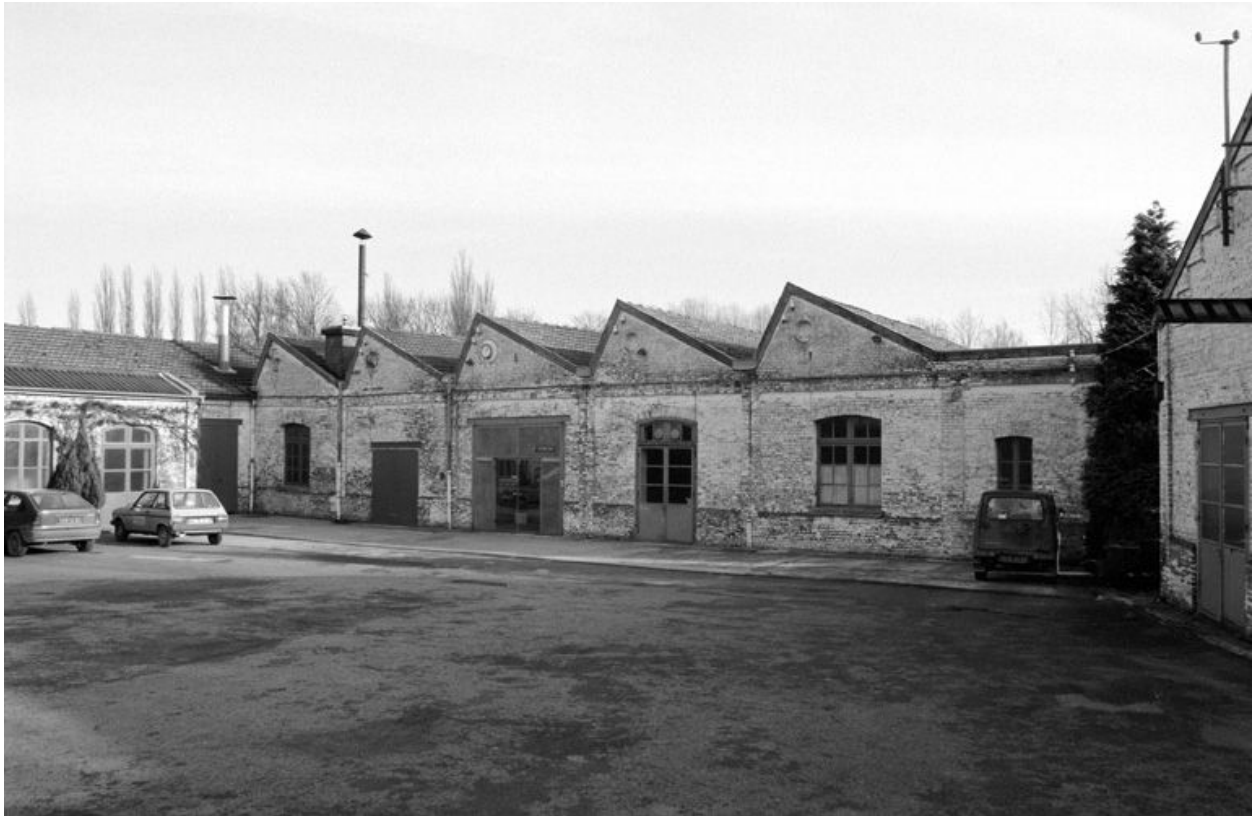
Atelier de fabrication, flanc ouest.
