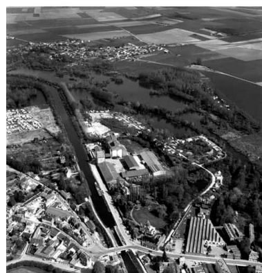
Vue aérienne, flanc sud. Phot. Phot'R IVR22_19888001182P
