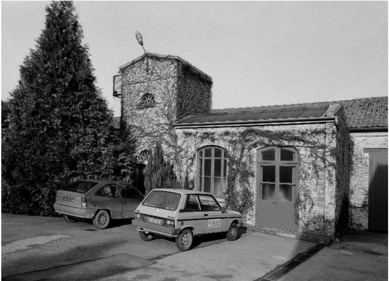
Transformateur. Elévation antérieure.
