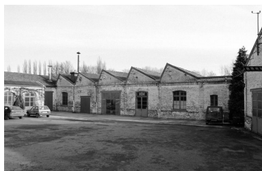
Atelier de fabrication, flanc ouest. Phot. Benoît Dufournier IVR22_19888000012Z
