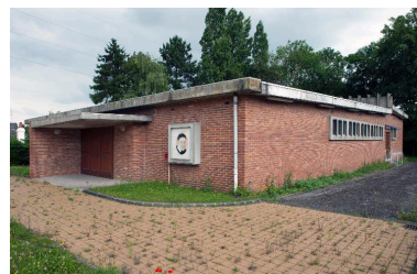
Elévation antérieure et latérale droite. Phot. Pierre Thibaut IVR31_20145903227NUCA
