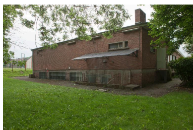
Elévation latérale droite et postérieure. Phot. Pierre Thibaut IVR31_20145903226NUCA
