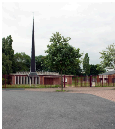
Vue d'ensemble. Phot. Pierre Thibaut IVR31_20145903219NUCA
