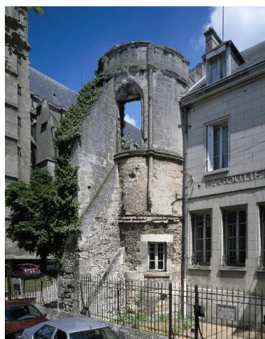
Vue de la tourelle appartenant à l'ancien évêché. Phot. Thierry Lefébure IVR22_19970200389VA
