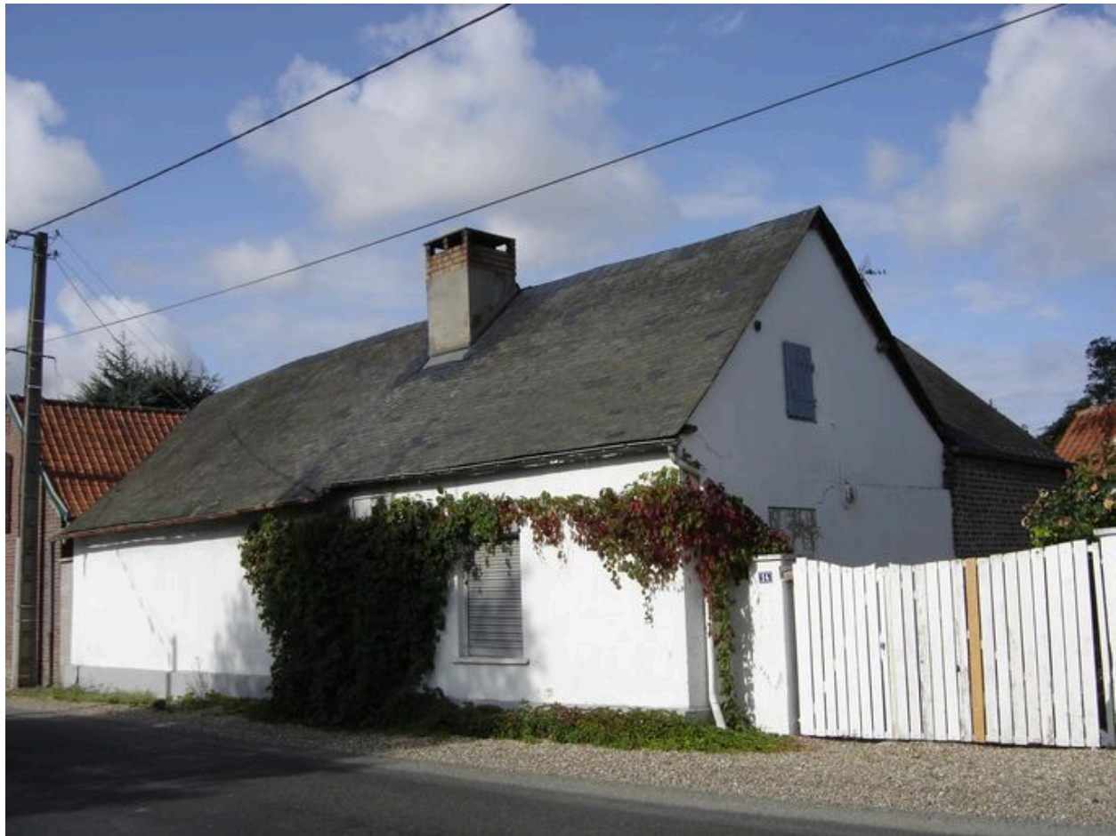
Vue du logis sur rue.
