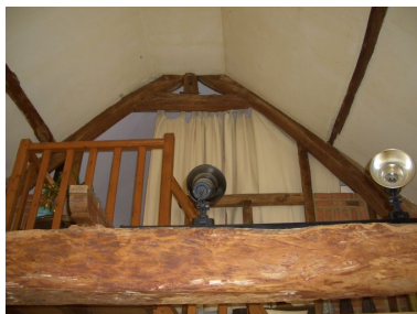
Vue d'une ferme de la charpente. Phot. Inès Guérin IVR22_20068005106NUCA
