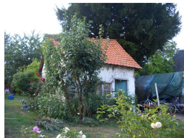
Vue générale de l'atelier de serrurier. Phot. Inès Guérin IVR22_20068005109NUCA
