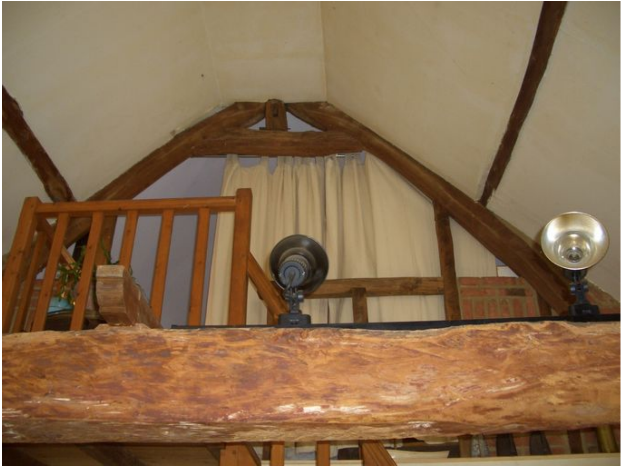
Vue d'une ferme de la charpente.
