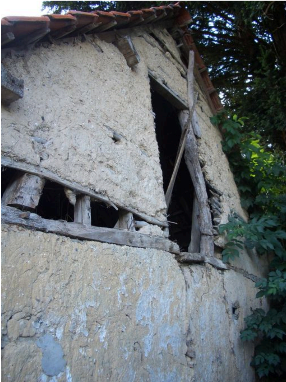
Vue du mur pignon en torchis avec gerbière.
