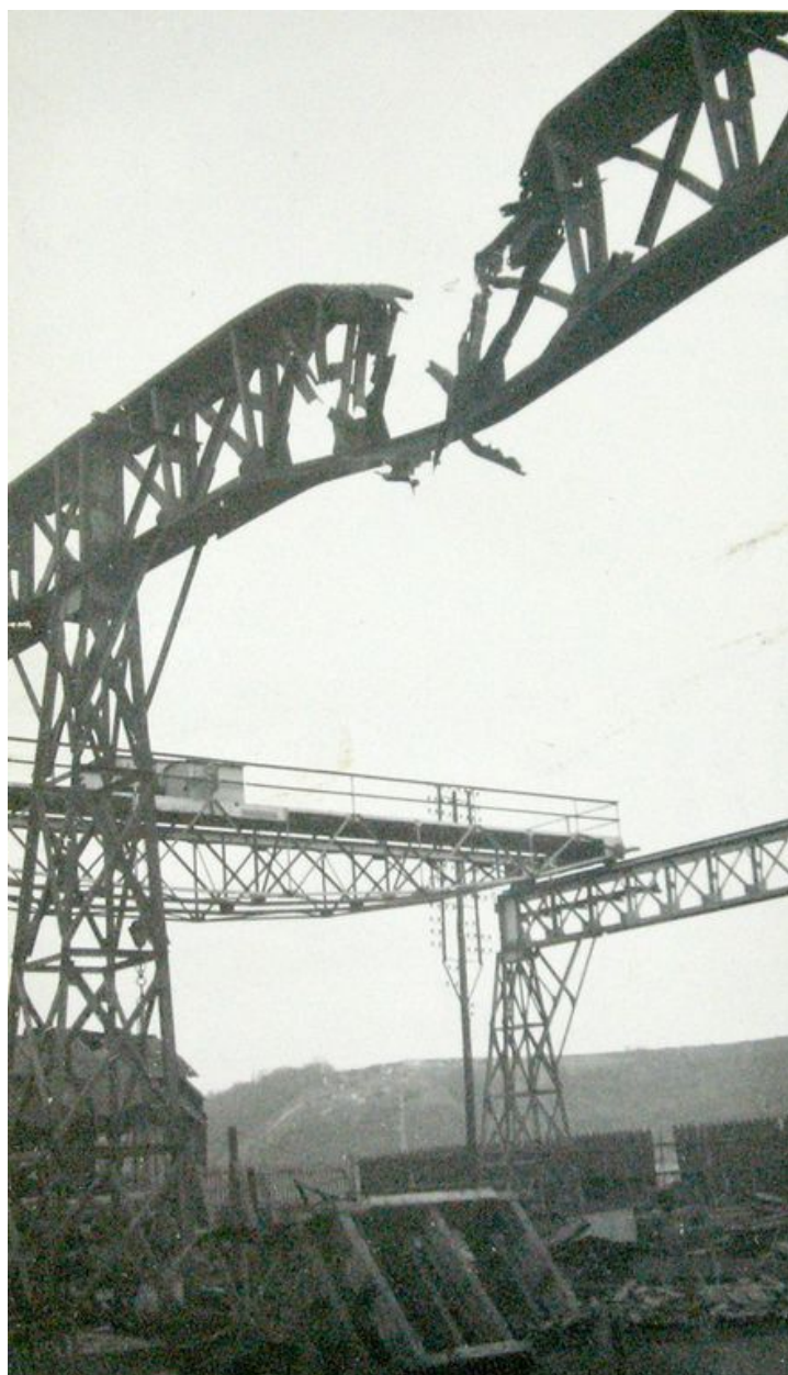
Poutre du chemin de roulement, état après les bombardements de 1944 (AD Oise ; 617W18128).
