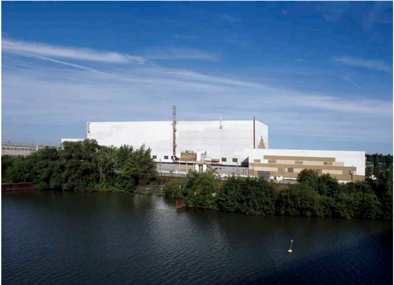
Bâtiment du recuit-continu.
