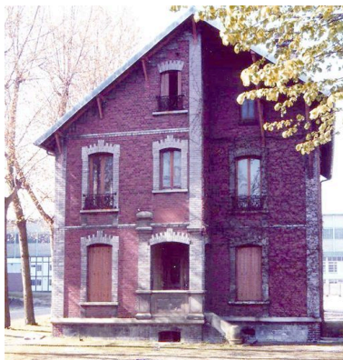
Façade est de la maison du directeur de l'usine des Ponts et Travaux en Fer, 1995 (archives d'entreprise).
