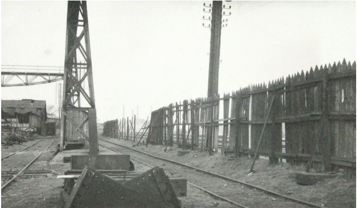
Clôture de la propriété Joret après les bombardements de 1944. A l'arrière-plan, les cheminées de l'usine de zinc de la Vieille-Montagne (AD Oise ; 617W18128).
