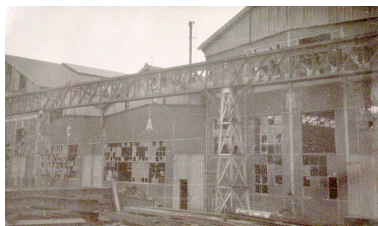
Dégâts des bombardements sur les ateliers de fabrication, 1944 (AD Oise ; 617W18128). Phot. Clarisse Lorieux IVR22_20086005060NUCAB
