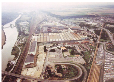
Vue aérienne du bâtiment du recuit continu construit par Arcelor au début des années 1980 et des bâtiments détruits (archives d'entreprise). Phot. Clarisse Lorieux IVR22_20086005102NUCAB
