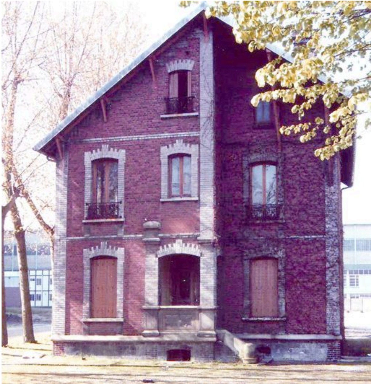
Façade est de la maison du directeur de l'usine des Ponts et Travaux en Fer, 1995 (archives d'entreprise).
