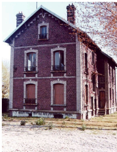
Façade ouest de la maison du directeur de l'usine des Ponts et Travaux en Fer prise en 1995 avant sa démolition (archives d'entreprise).
