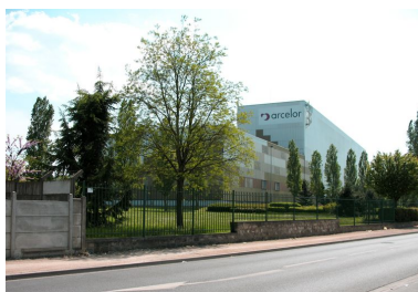
Le recuit continu d'Arcelor construit à l'emplacement de l'usine d'Henri Joret. Phot. Clarisse Lorieux IVR22_20086005155NUCA
