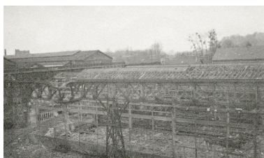
Bombardement du chemin de roulement du pont-roulant, 1944 (AD Oise ; 617W18128). Phot. Clarisse Lorieux IVR22_20086005057NUCAB
