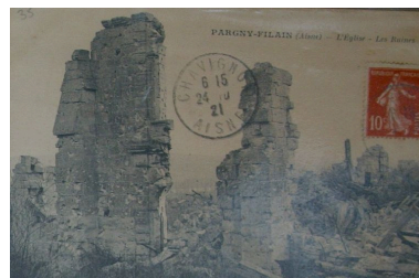
Vue de l'église en ruine (coll. part). Phot. Inès Guérin IVR22_20030202880NUCAB
