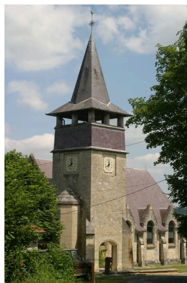
Vue latérale. Phot. Inès Guérin IVR22_20030202864NUCA
