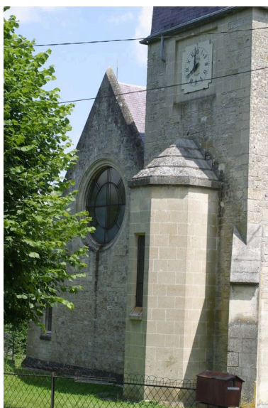
Vue de la façade ouest. Phot. Inès Guérin IVR22_20030202865NUCA
