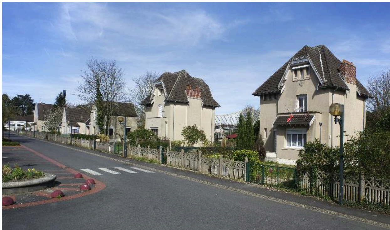
Vue générale des logements.
