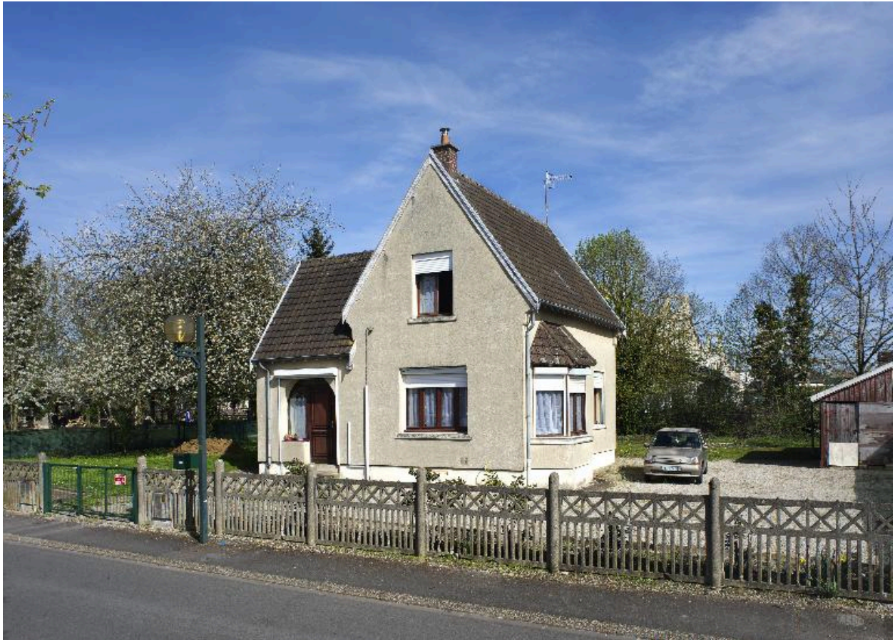
Maison, 12 place Herment. Au premier plan, la clôture d'origine.
