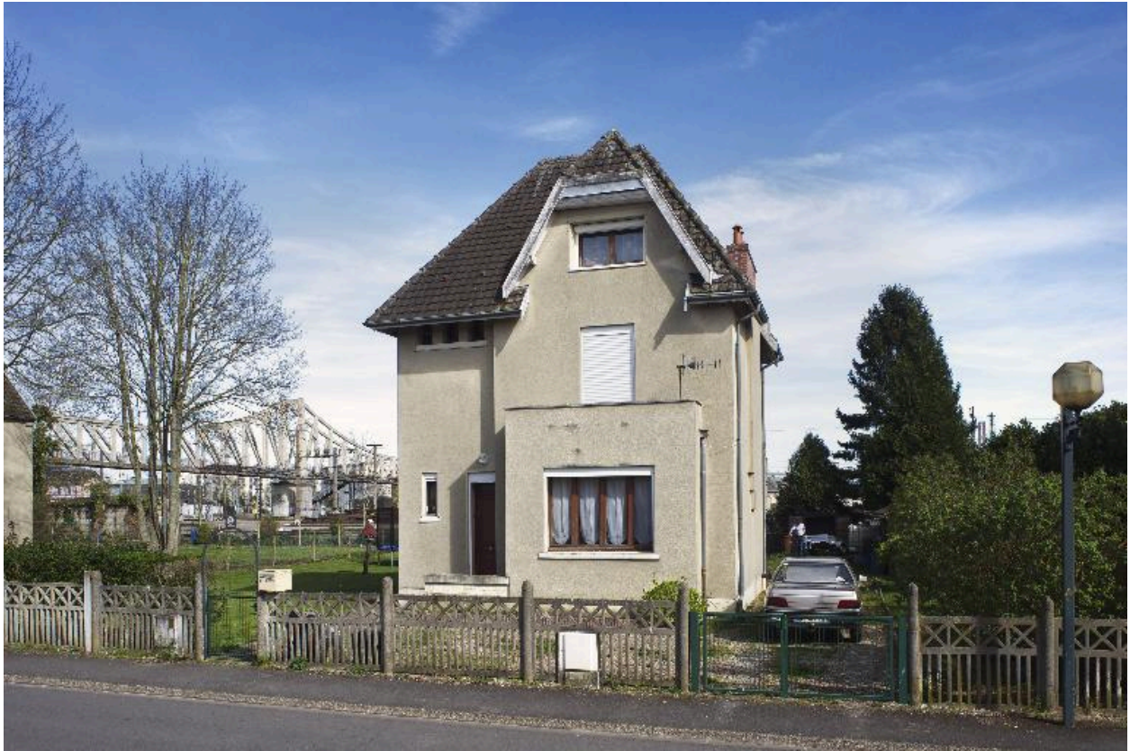
Maison, 8 place Herment. Au premier plan, la clôture d'origine.
