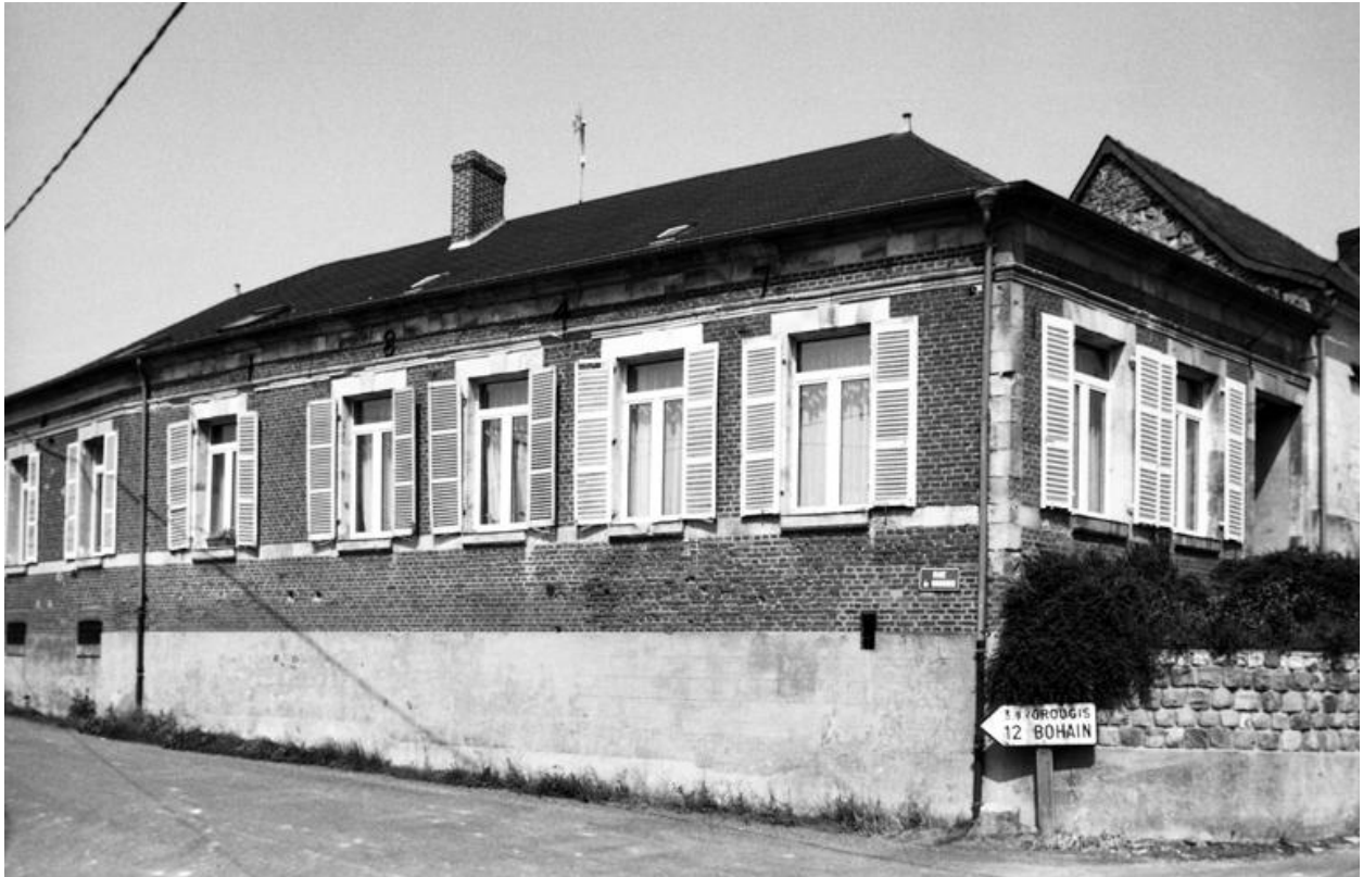
Vue de la façade sur rue.
