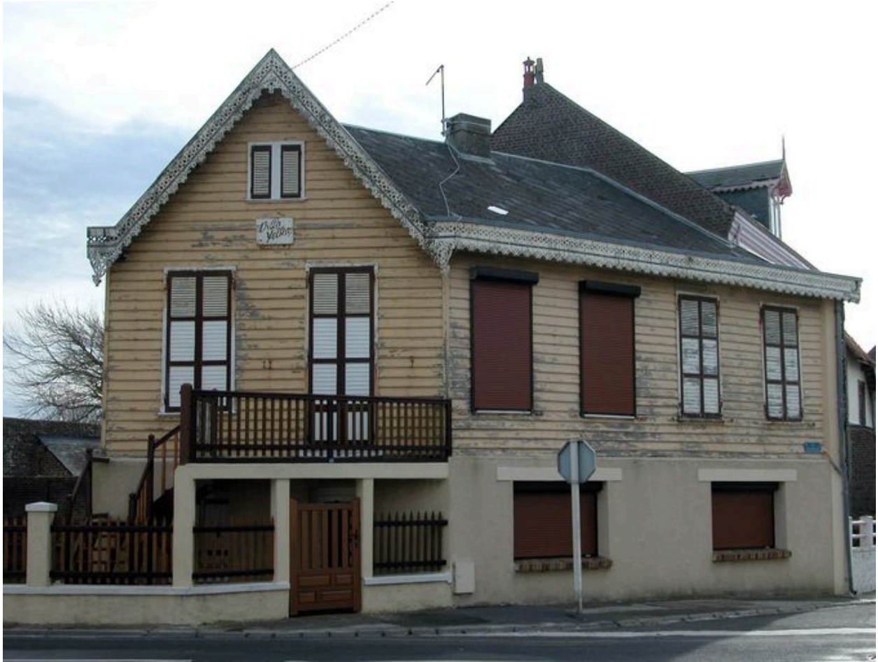
Vue d'ensemble depuis la rue du Général-Leclerc.
