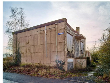
Élévation nord et ouest de l'édifice. Phot. Pierre Thibaut IVR32_20176200046NUCA
