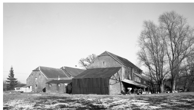
Vue générale, depuis le sud. Phot. Thierry Lefébure IVR22_19960200963X
