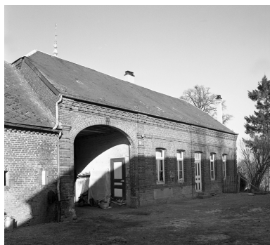
Elévation sur cour du logis et passage menant à l'extérieur. Phot. Thierry Lefébure IVR22_19960200959X
