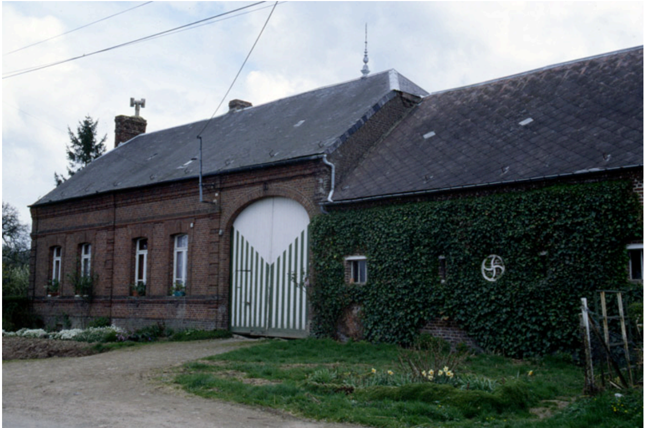
Elévation sur rue du logis et de l'étable attenante.
