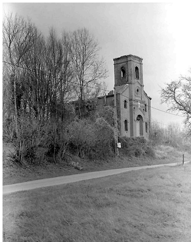
Vue générale depuis le sud-ouest. Phot. Laurent Jumel IVR22_19970202214X
