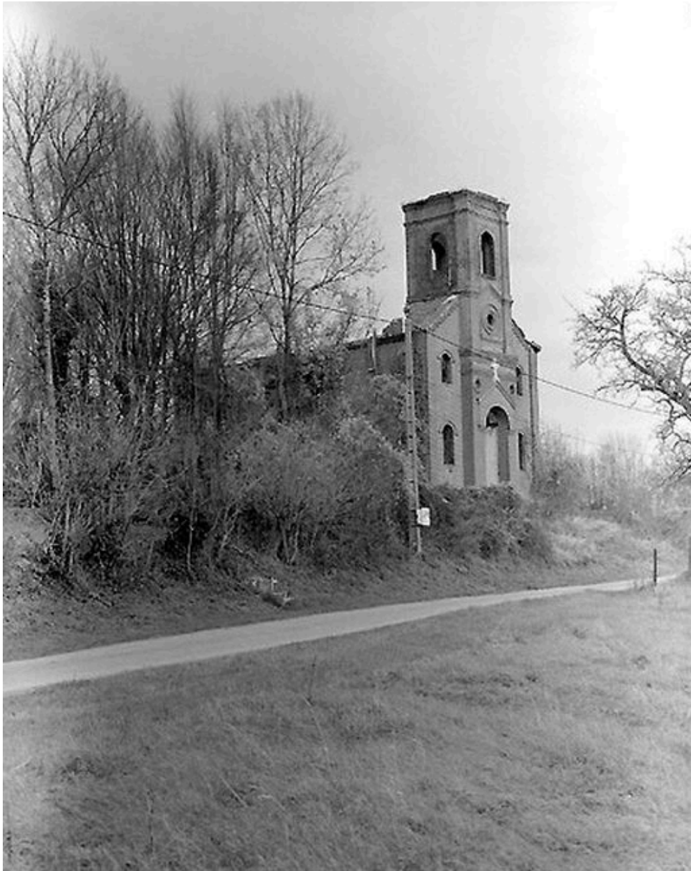
Vue générale depuis le sud-ouest.
