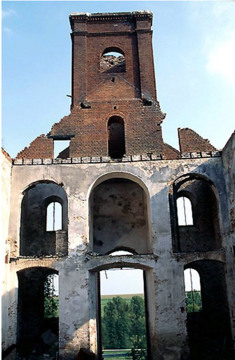
vue du clocher-porche, côté intérieur.
