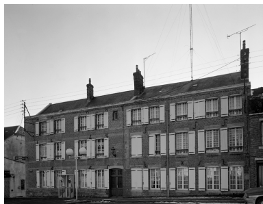
Vue générale. Phot. Thierry Lefébure IVR22_19960201006V
