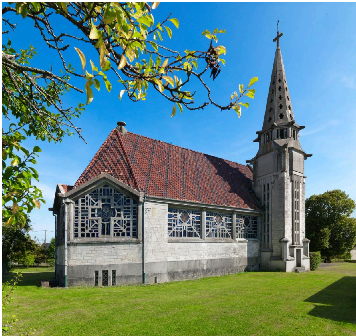
Vue extérieure de l'élévation ouest de l'église, montrant ses baies à réseau de béton.
