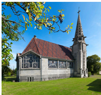
Vue extérieure de l'élévation ouest de l'église, montrant ses baies à réseau de béton. Phot. Thierry Lefébure IVR32_20210200198NUCA
