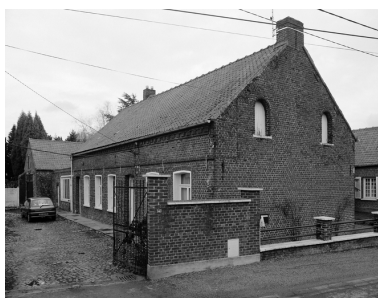
Vue générale du logis depuis la rue. Phot. Philippe Dapvril IVR31_20055900021X
