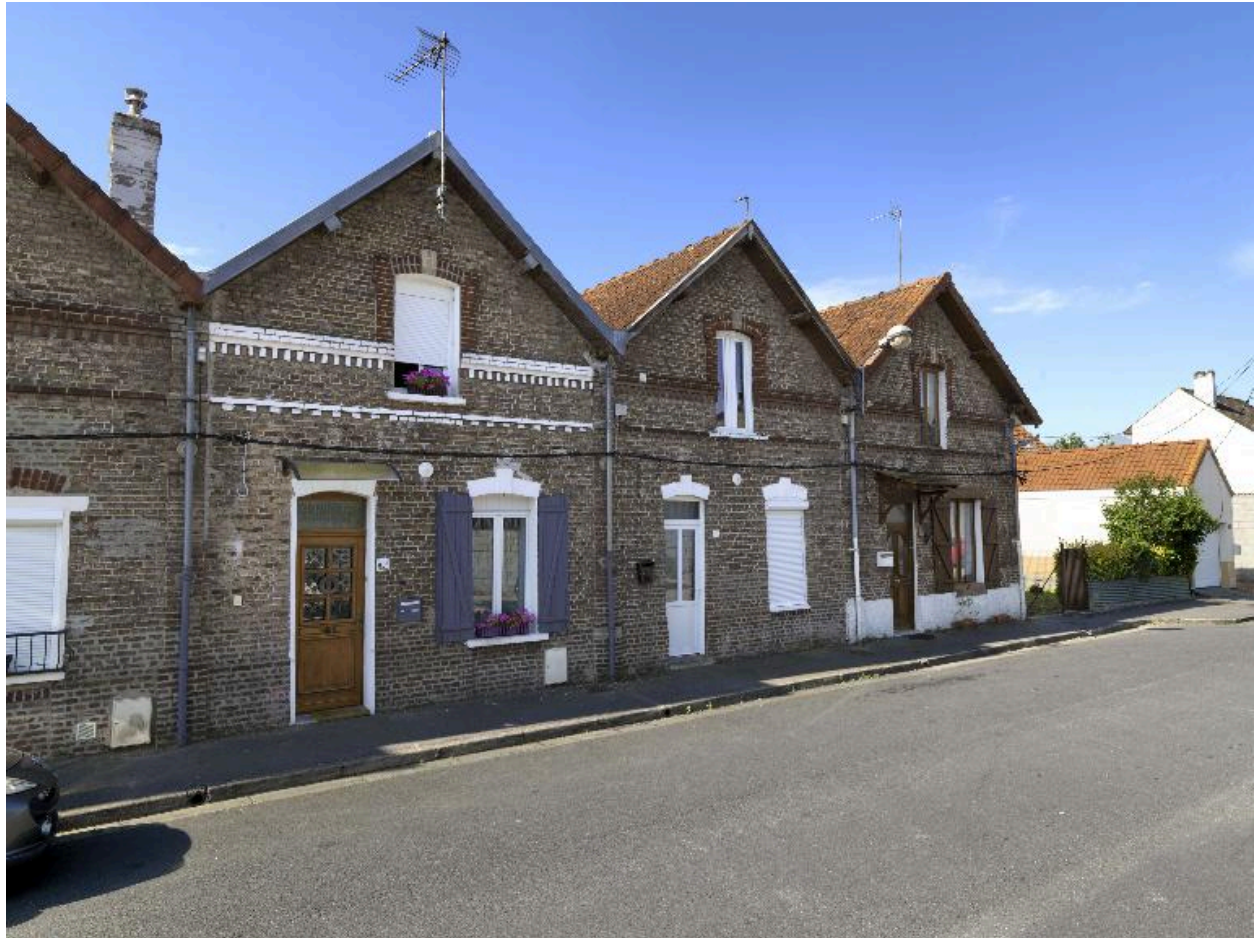
Logements ouvriers de la rue Nouvelle-Cité-Saint.
