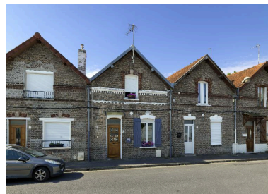
Logements ouvriers de la rue Nouvelle-Cité-Saint, façades des n° 19, 21 et 23. Phot. Thierry Lefébure IVR22_20168000294NUC2A
