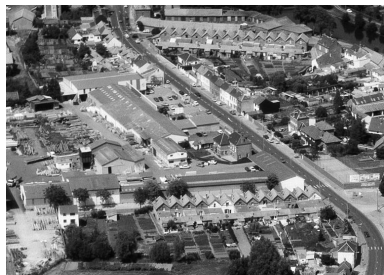
Vue aérienne générale de 1990. Phot. Phot'R IVR32_20178005042NUCA
