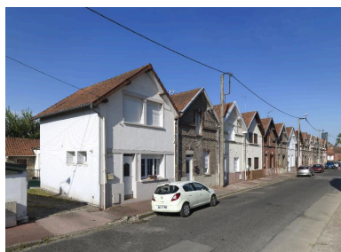
Logements ouvriers de la rue Henri-Piquet. Phot. Thierry Lefébure IVR22_20168000289NUC2A
