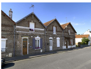
Logements ouvriers de la rue Nouvelle-Cité-Saint. Phot. Thierry Lefébure IVR22_20168000293NUC2A
