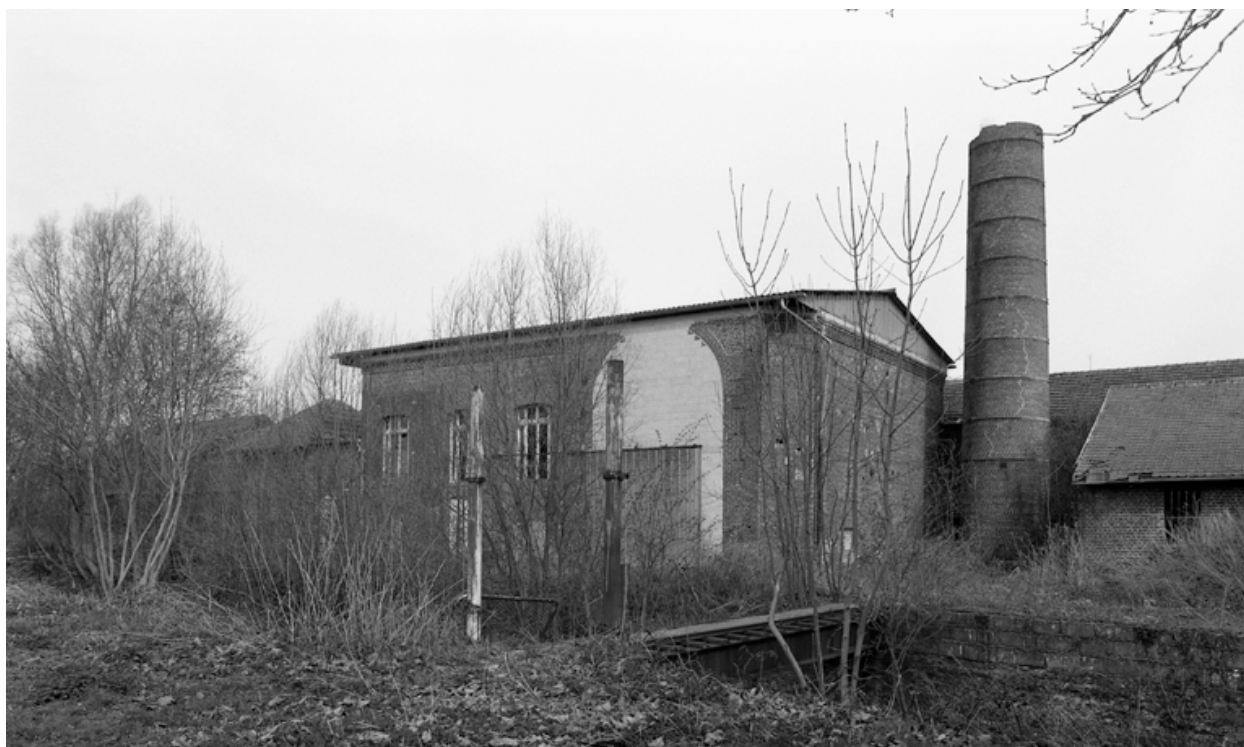
Vue de la cheminée et de la chaufferie ?
