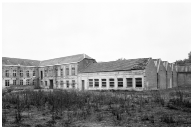
Vue partielle de l'usine depuis la rue. Phot. Thierry Lefébure IVR22_19960200568V
