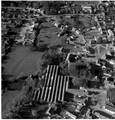
Vue aérienne de l'usine, depuis l'est. Phot. Phot'R IVR22_19890201315P
