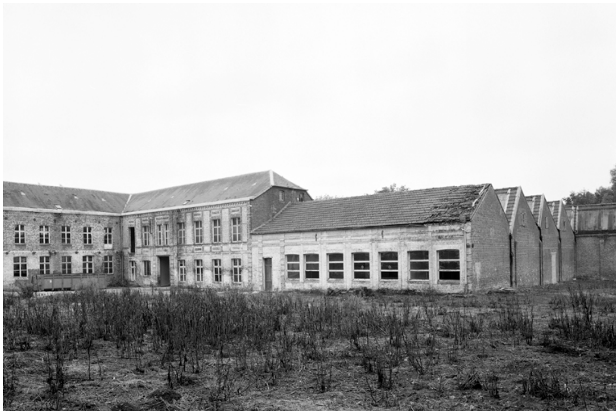
Vue partielle de l'usine depuis la rue.
