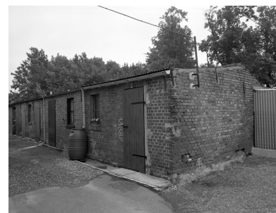
Série de resserres dépendant des logements de la cité ouvrière construite pour les employés du tissage. Phot. Thierry Lefébure IVR22_19960200558X
