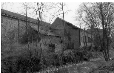
Vue partielle des bâtiments au sud de l'usine. Phot. Christiane Riboulleau IVR22_19960200428Z
