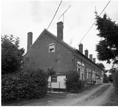
Vue des logements ouvriers qui composent la partie ouest de la cité construite pour les employés du tissage. Phot. Thierry Lefébure IVR22_19960200581V
