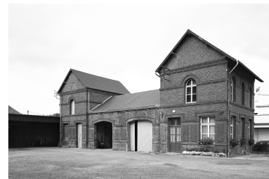
Vue des remises et du logement du cocher. Phot. Thierry Lefébure IVR22_19960200580V
