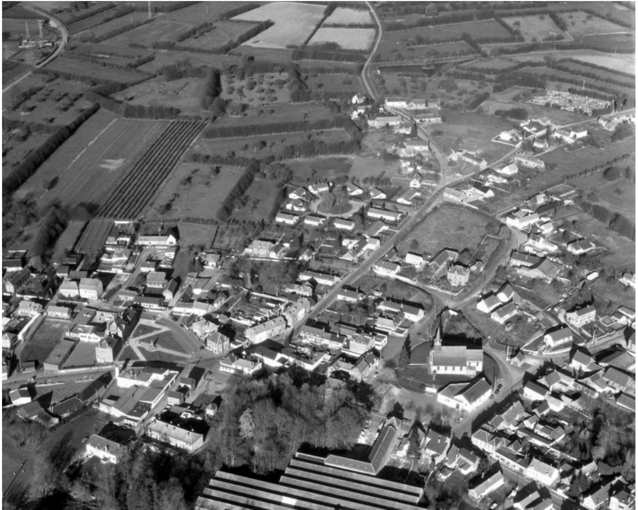
Vue aérienne de l'usine, depuis le sud-est.
