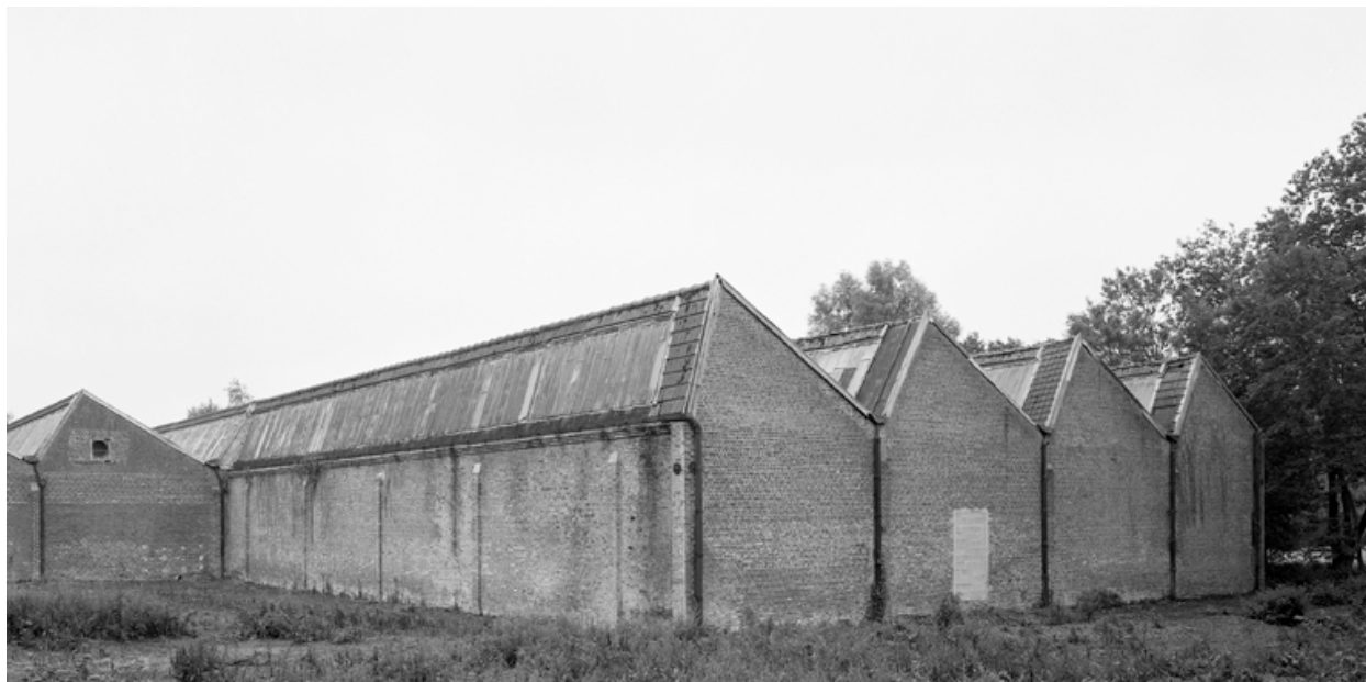
Vue partielle de l'atelier de fabrication, depuis le nord-ouest.
