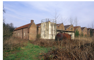
Vue partielle sud-est de l'atelier de fabrication et d'un réservoir industriel. Phot. Christiane Riboulleau IVR22_19960200167ZA
