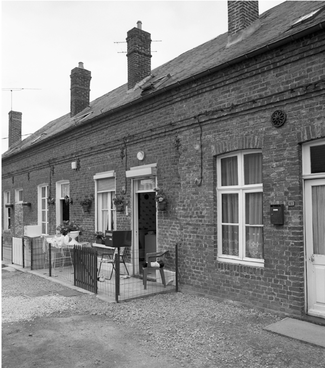
Vue partielle de la façade des logements ouvriers qui composent la partie ouest de la cité construite pour les employés du tissage.
