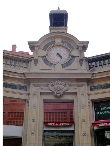
Vue de détail de l'horloge et du cartouche portant les dates 1833-1883. Phot. Isabelle Barbedor IVR22_20048010833NUCA
