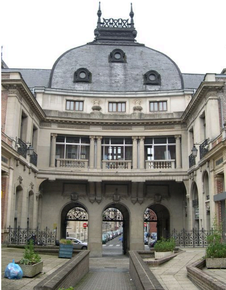
Vue du corps de passage depuis la cour.
