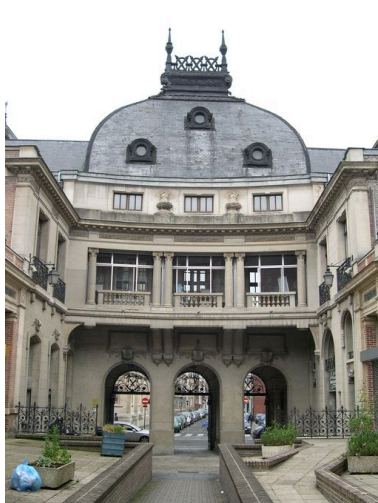
Vue du corps de passage depuis la cour. Phot. Isabelle Barbedor IVR22_20048010832NUCA
