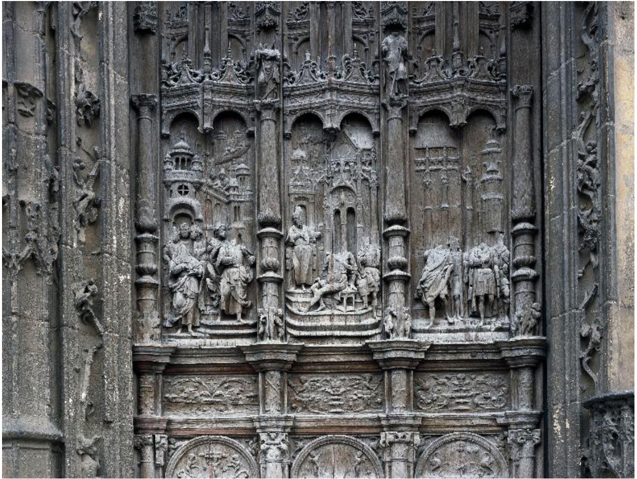
Vue de la partie supérieure du vantaux gauche.
