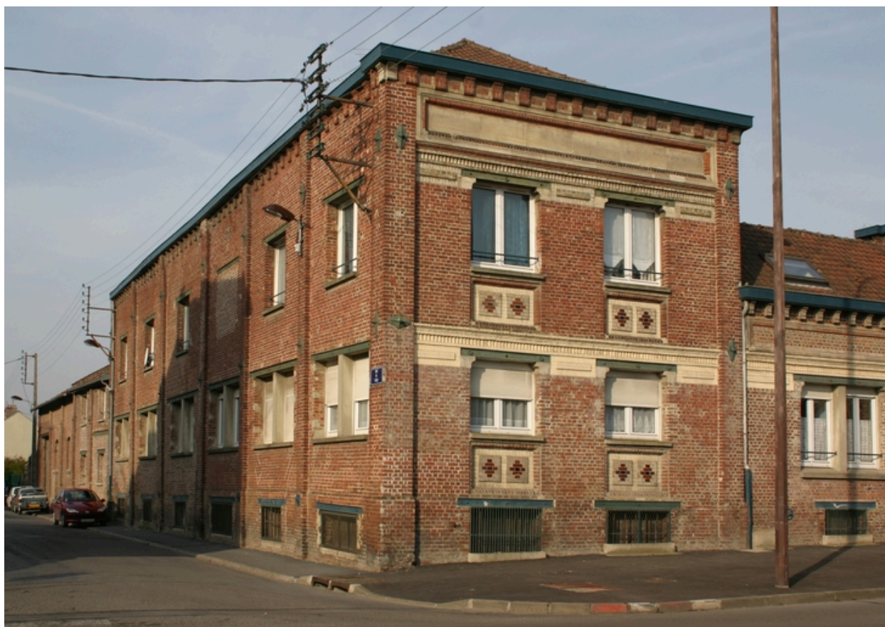
Anciens ateliers de bobinage et de retorderie, à l'angle des rues de Tour-Y-Val et de Vicq.
