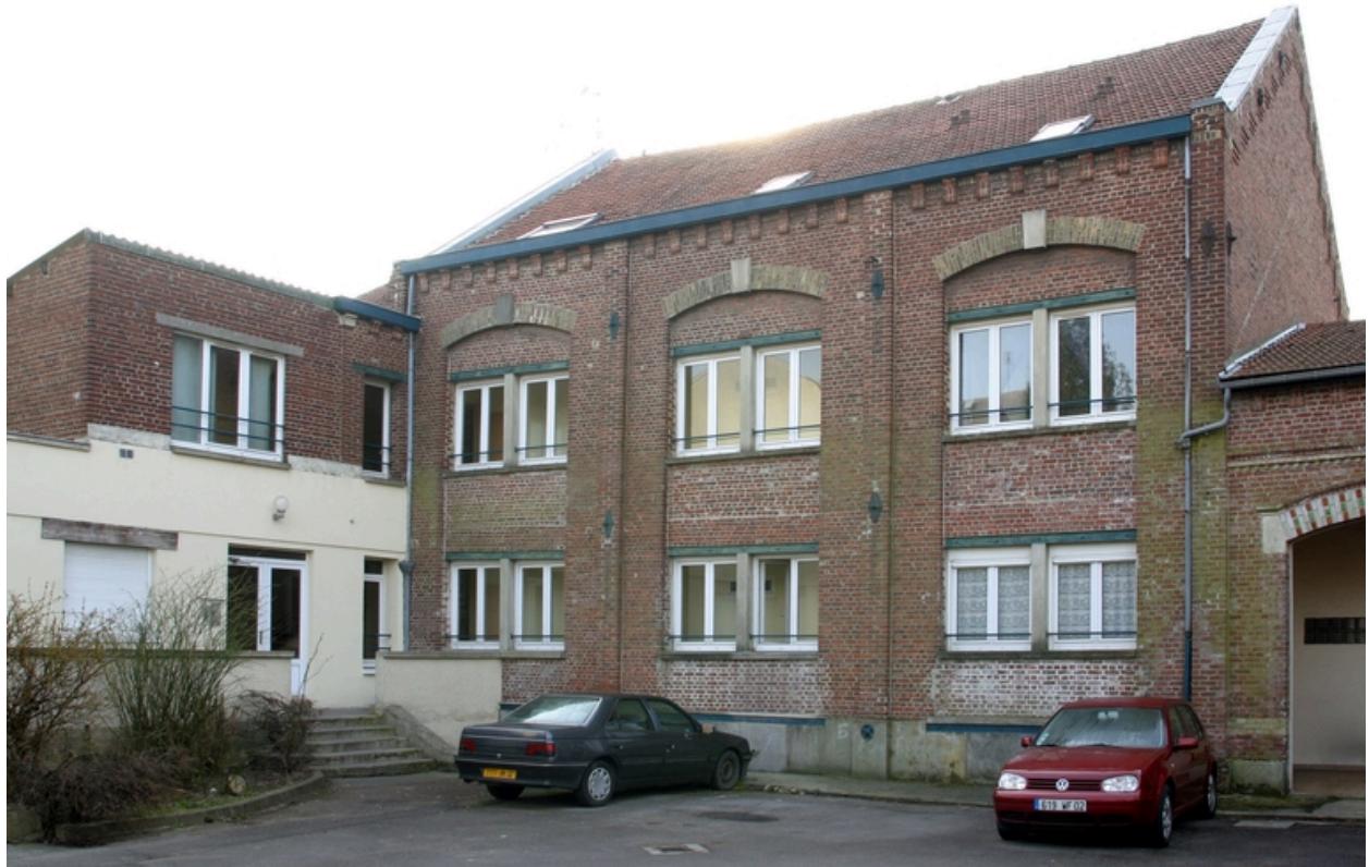
Façades postérieures des anciens bobinage et retorderie.
