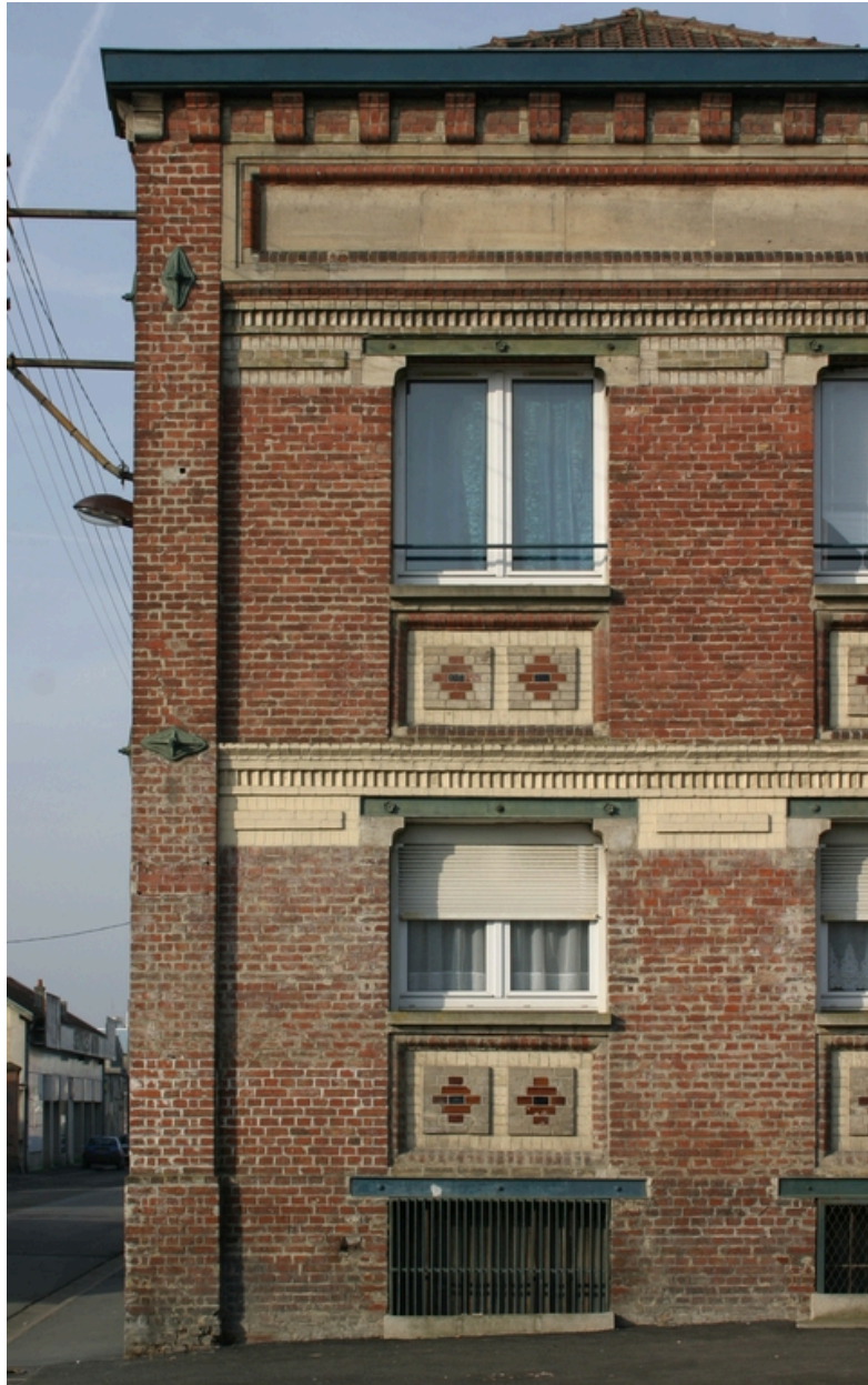
Détail d'une travée de l'ancien atelier de bobinage.
