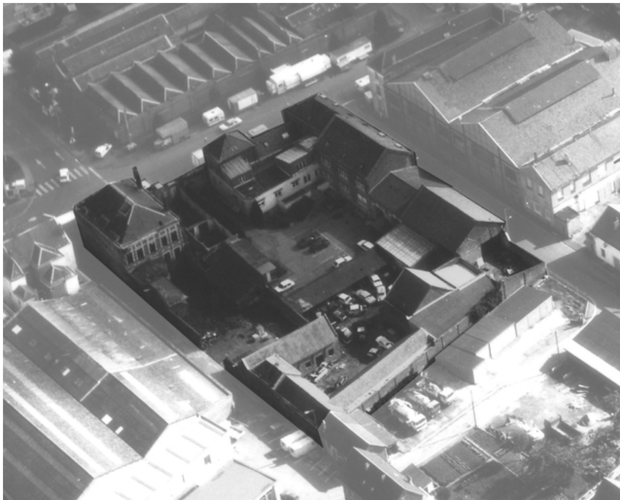
Vue aérienne du site, 1989.
