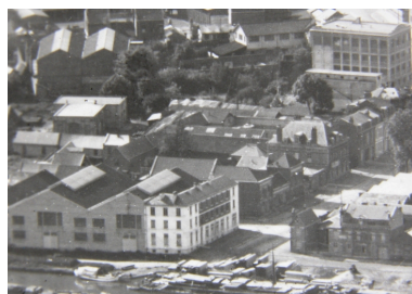
Vue aérienne du site vers 1925 (BM Saint-Quentin). Phot. Pillet Frédéric IVR22_20050205218NUCAB
