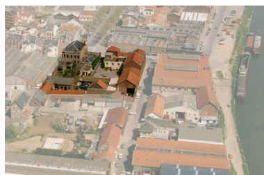
Vue aérienne du site vers 1989 (BM Saint-Quentin) Phot. Pillet Frédéric IVR22_20050205221NUCAB
