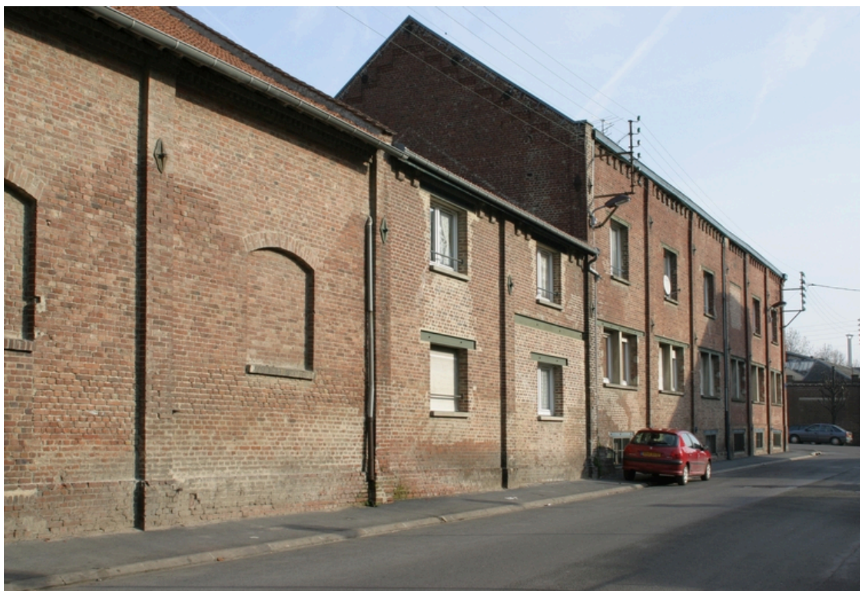
Anciens ateliers de bobinage et de retorderie, rue de Vicq.
