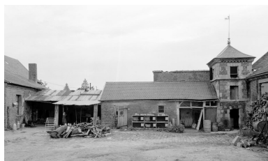
Vue partielle de la cour, côté gauche. Phot. Jean-Michel Perrin IVR22_19846000966X
