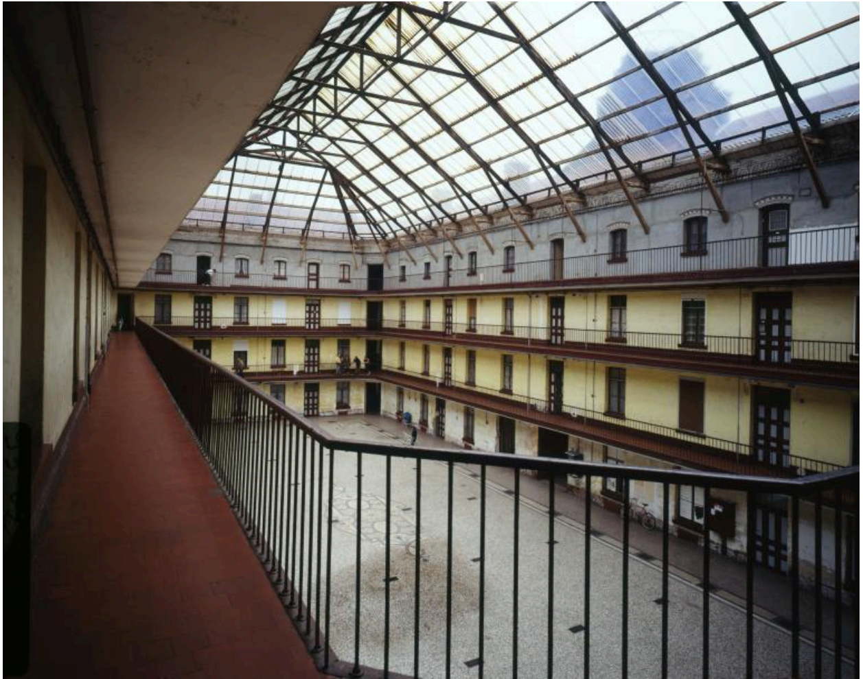
Vue de la cour intérieure de l'aile centrale, depuis le balcon du second étage.
