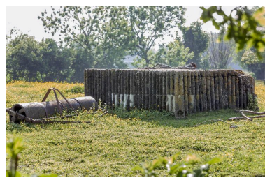
Vue arrière de l'édicule, vers le sud-ouest Phot. Jean-Marc Ramette IVR31_20145905506NUCA
