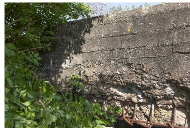
Partie de l'élévation sud Phot. Jean-Marc Ramette IVR31_20145905498NUCA
