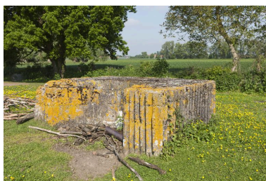
Edicule vers le nord-ouest Phot. Jean-Marc Ramette IVR31_20145905509NUCA
