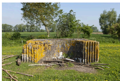
Edicule, vers le nord Phot. Jean-Marc Ramette IVR31_20145905508NUCA
