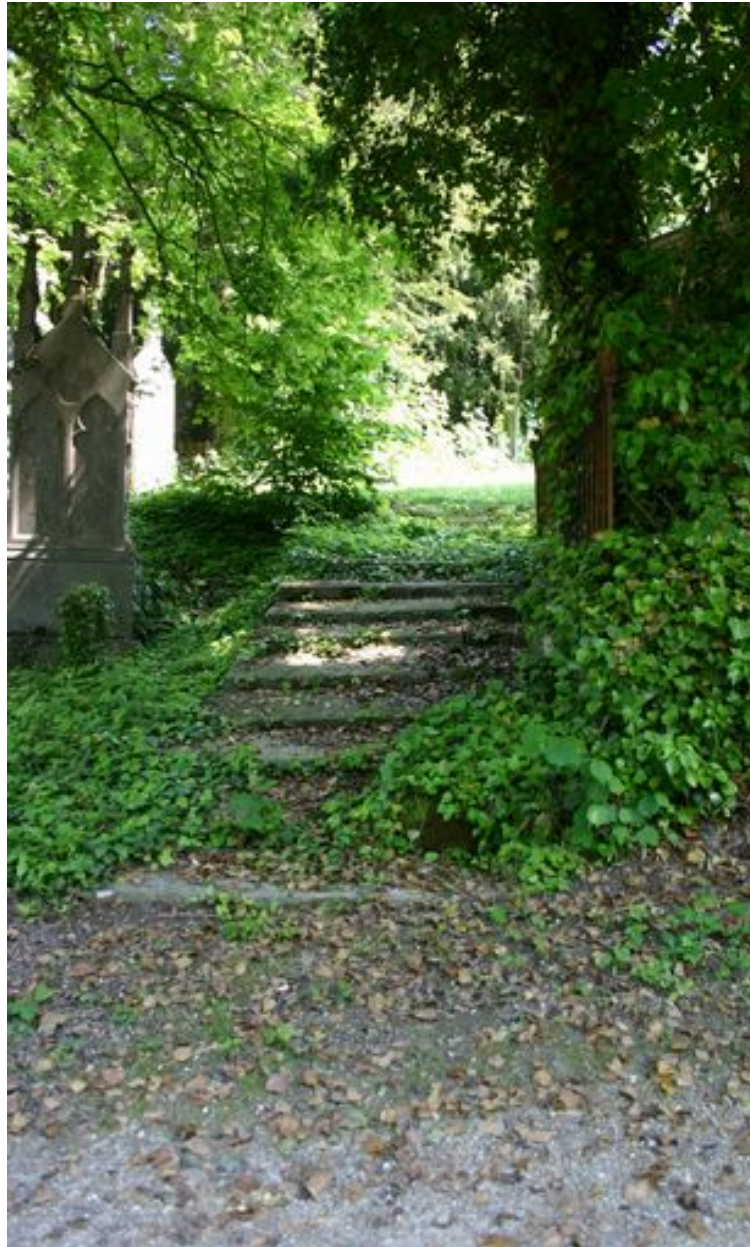
Vue de l'escalier donnant accès à l'intérieur de la plaine D et situé à l'angle sud-ouest.
