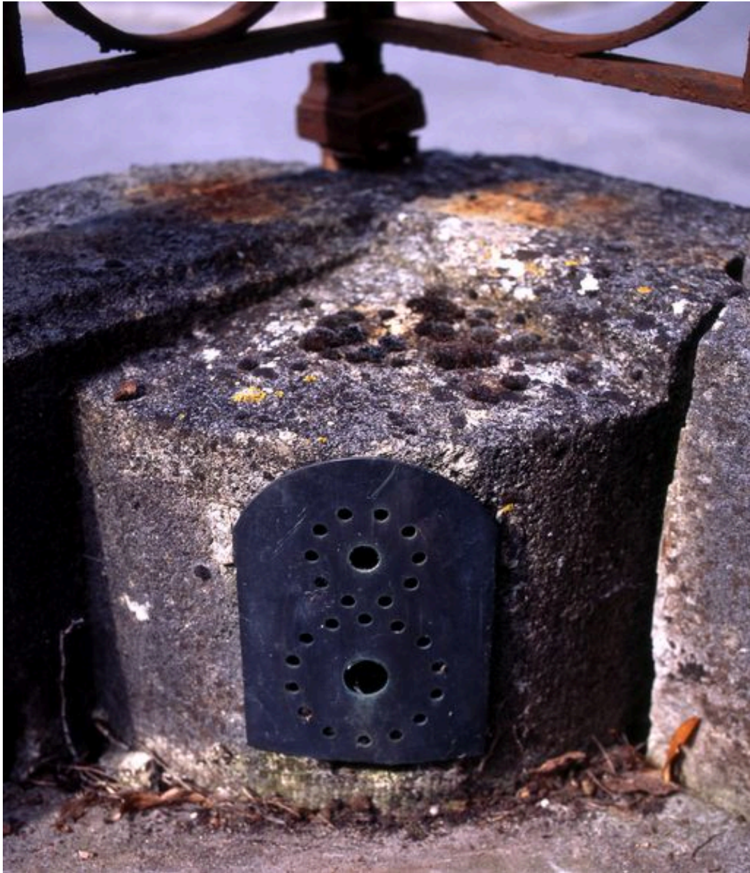
Vue de détail sur la bouche d'aération du caveau.
