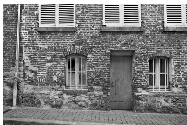
Détail du rez-de-chaussée du logis situé rue Raoul de Coucy. Phot. Pierre-Yves Brest IVR22_19990207130Z
