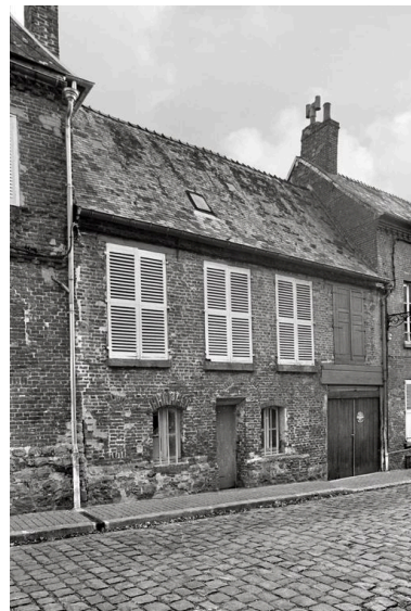
Vue du logis situé rue Raoul de Coucy. Phot. Pierre-Yves Brest IVR22_19990207129Z
