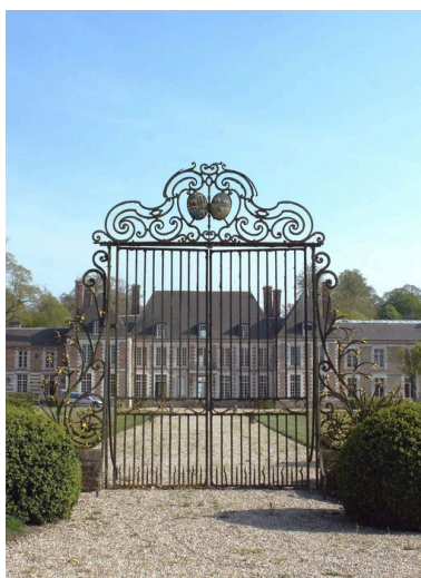
Grille principale. Phot. Marie-Laure Monnehay-Vulliet IVR22_20118000072NUCA
