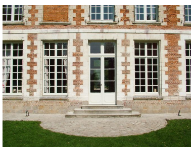
Détail de la partie centrale de la façade du logis sur jardin. Phot. Frédéric Fournis IVR22_20118001283NUCA
