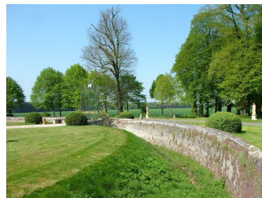
Fossé et contrescarpe délimitant la cour. Phot. Frédéric Fournis IVR22_20118001266NUCA
