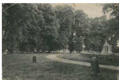
Vue partielle de l'esplanade, du mur de clôture et du portail, carte postale, années 1920 (coll. part.). Phot. Monnehay-Vulliet Marie-Laure IVR22_20118000640NUCA
