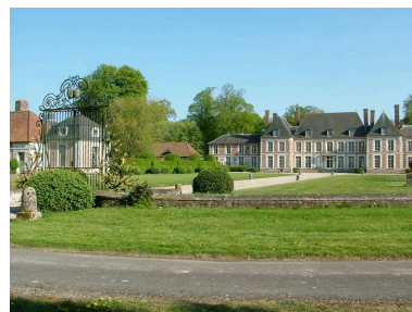
Vue générale depuis l'esplanade. Phot. Frédéric Fournis IVR22_20118001250NUCA
