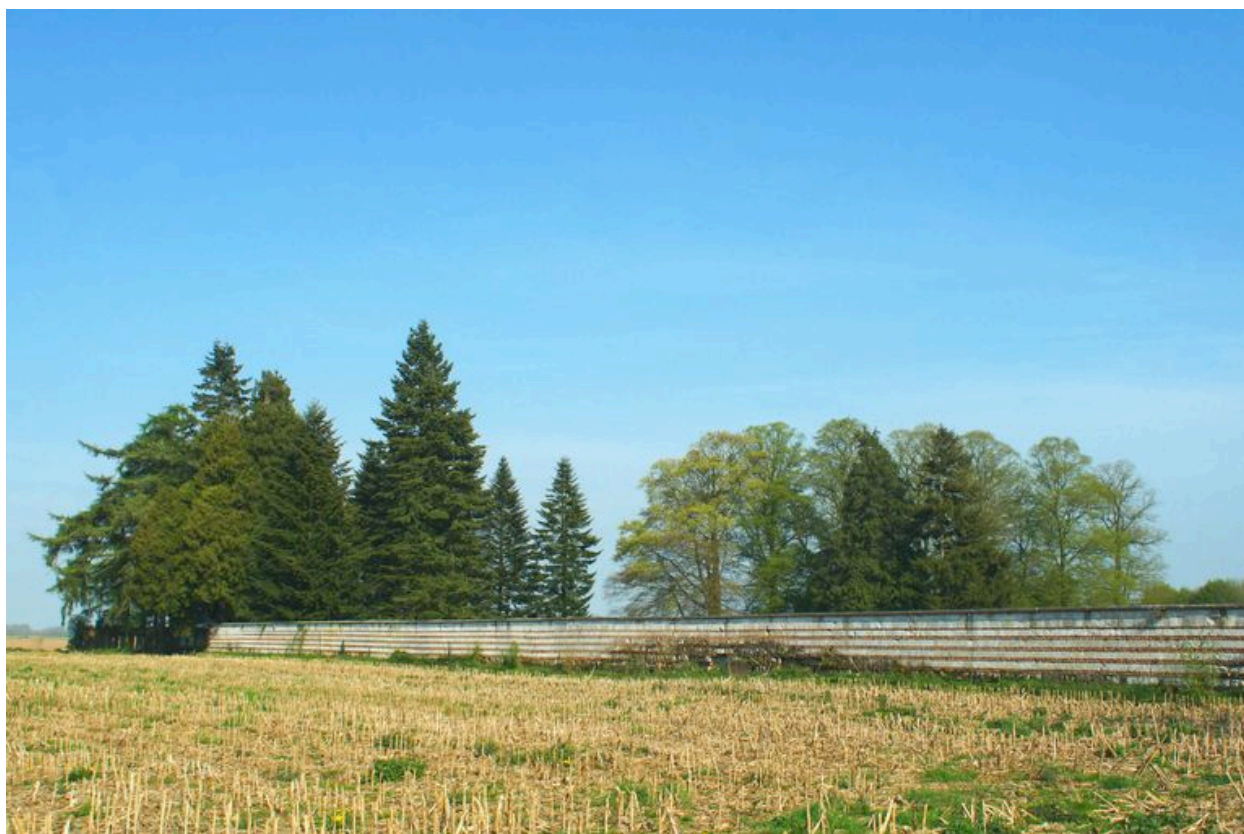
Mur de clôture du parc au nord.
