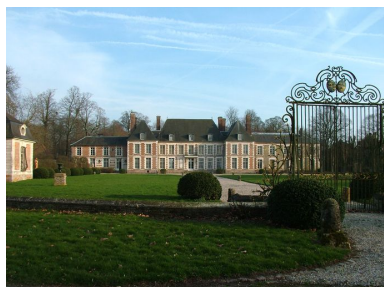
Grille principale, cour et logis, avec le chartrier à gauche. Phot. Frédéric Fournis IVR22_20118001110NUCA
