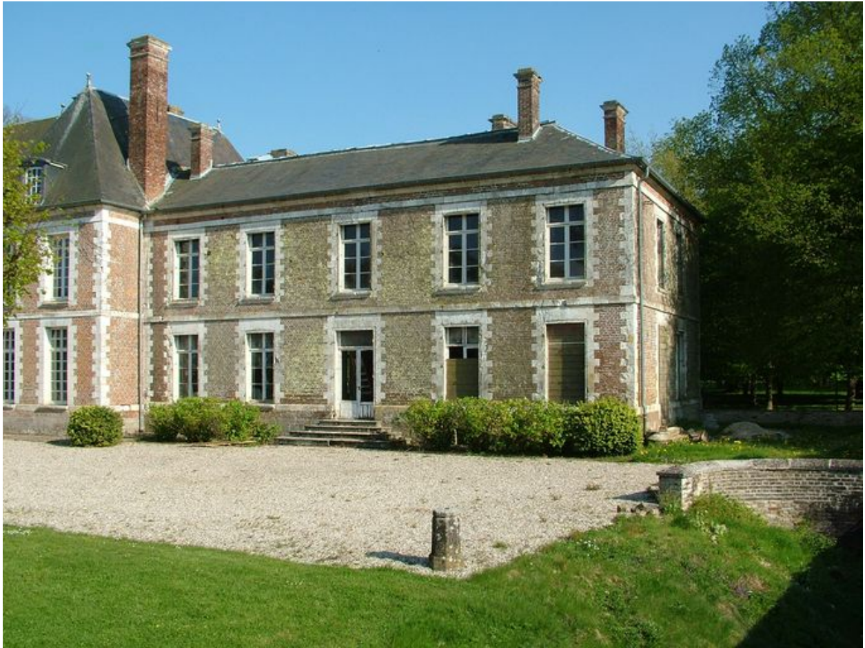
Corps de logis moderne, vue sur cour.
