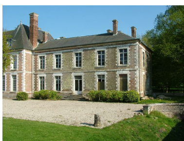
Corps de logis moderne, vue sur cour. Phot. Frédéric Fournis IVR22_20118001249NUCA
