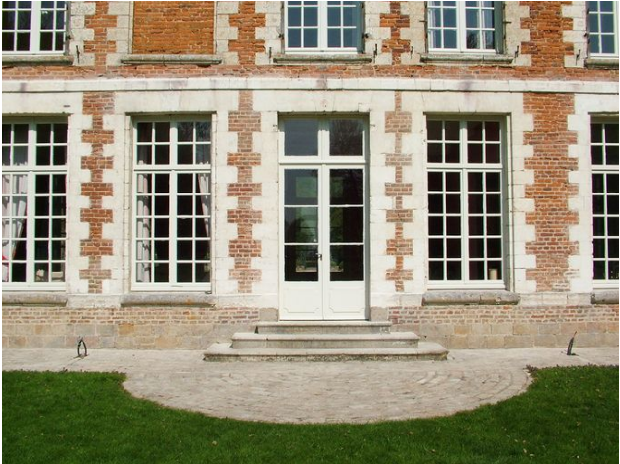
Détail de la partie centrale de la façade du logis sur jardin.
