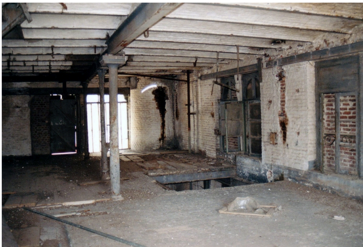
Vue intérieure des ateliers, 1996 (BM Saint-Quentin).
