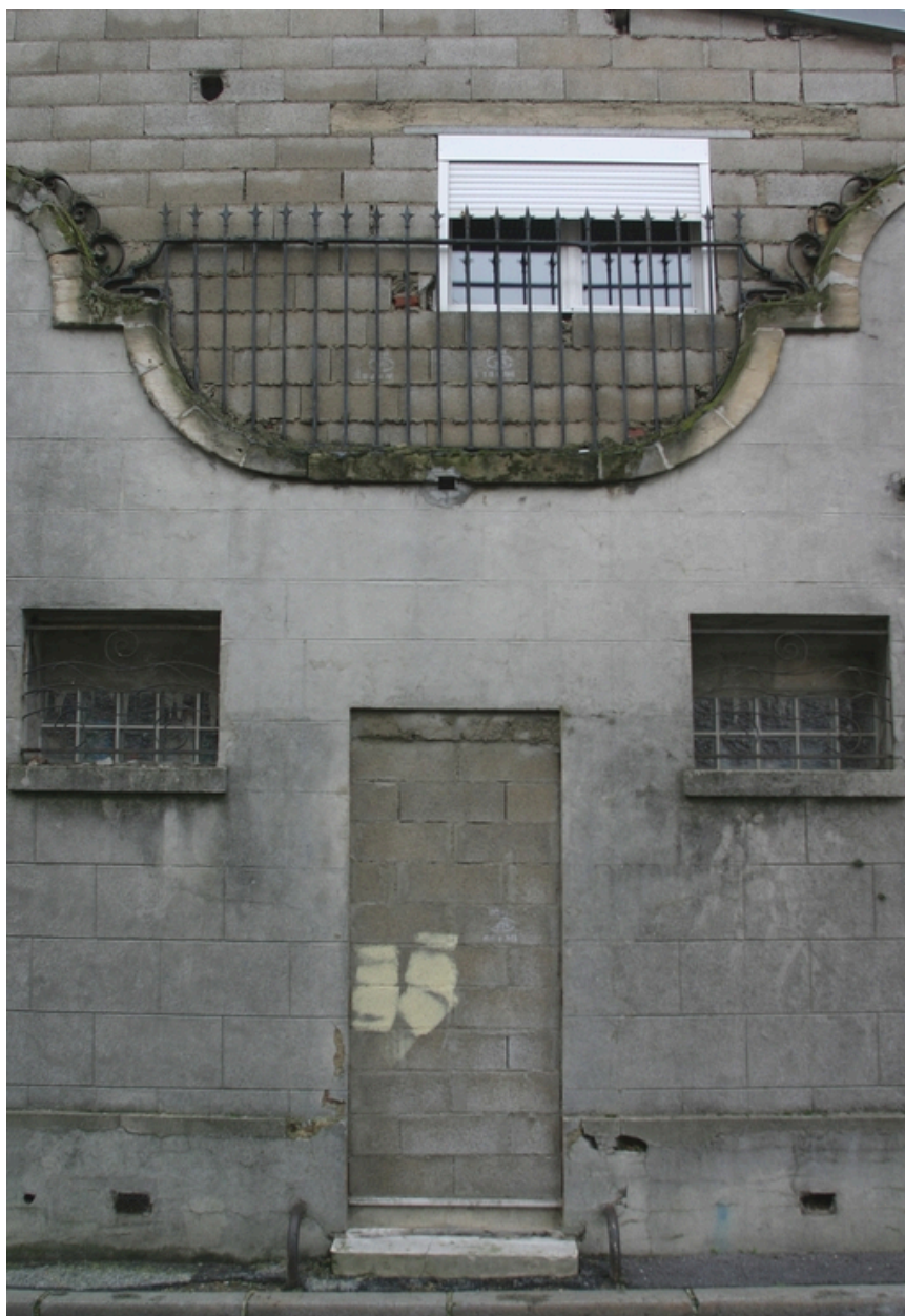
Détail de la façade du logement patronal, rue de Bagatelle.
