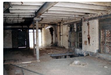
Vue intérieure des ateliers, 1996 (BM Saint-Quentin).
