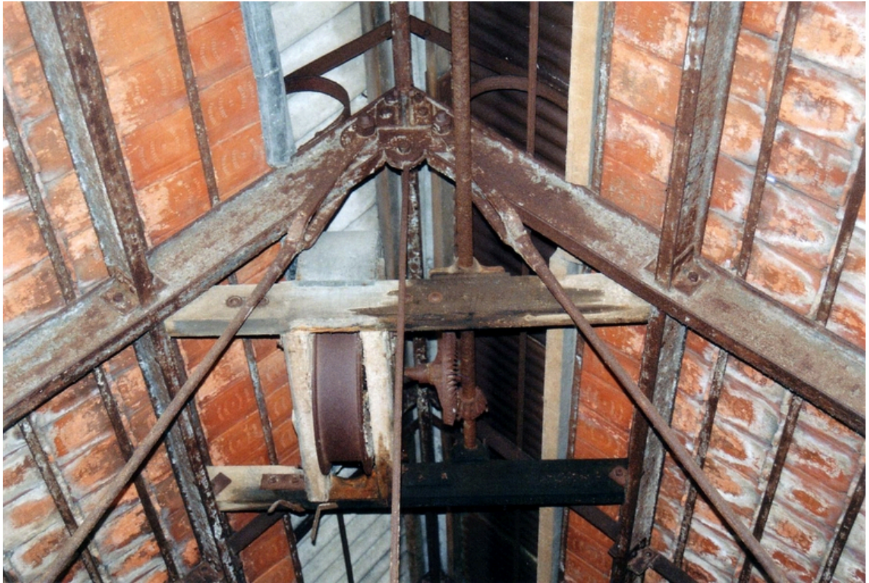
Détail de la charpente métallique des ateliers, 1996 (BM Saint-Quentin).
