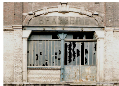
Détail de la façade sur rue, 1996 (BM Saint-Quentin). Phot. Pillet Frédéric, Autr. Alain Pecquet IVR22_20060205566NUCAB
