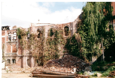
Façade sur cour des ateliers en cours de démolition, 1996 (BM Saint-Quentin).
